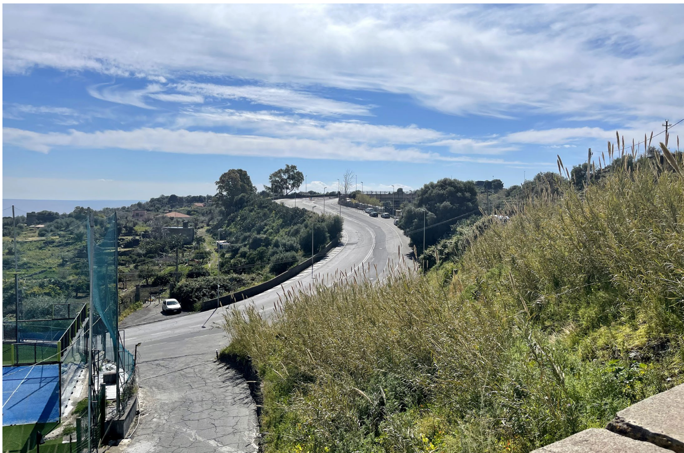
13. Vista dell'area d'intervento (a destra) e di via Stazione
