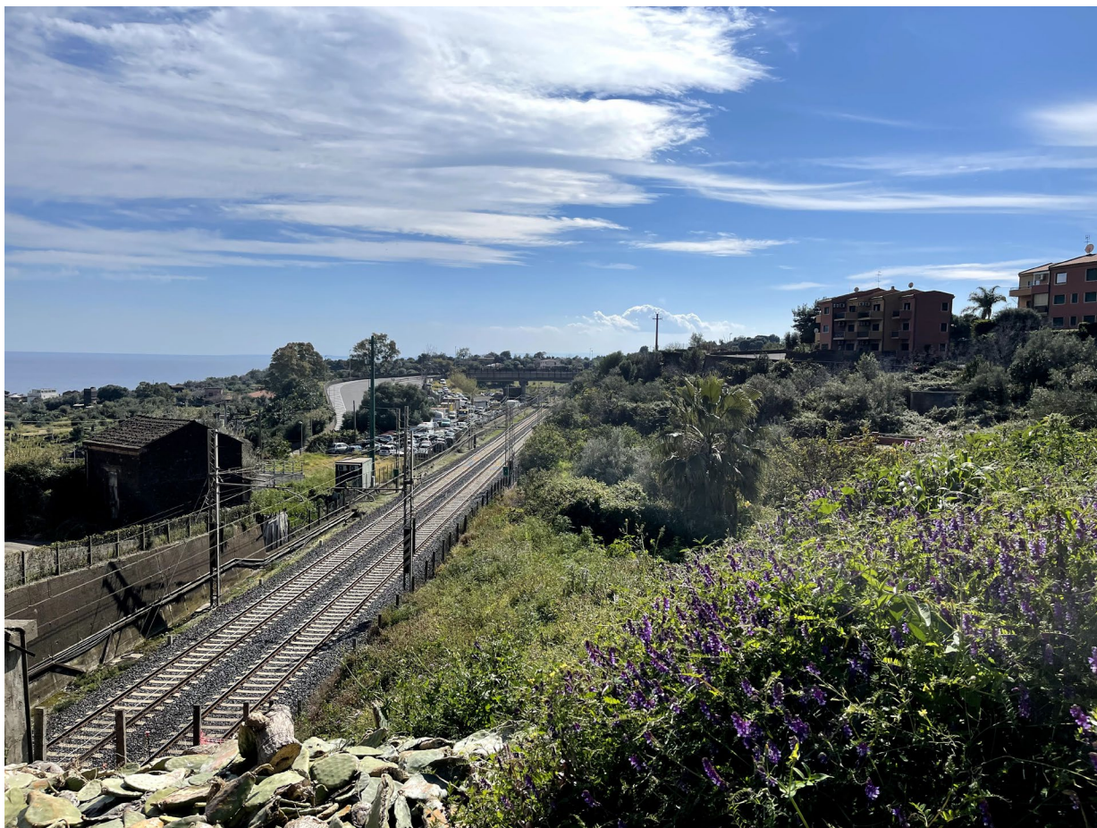
1. Foto dell'area d'intervento dalla strada sovrastante l'ingresso della galleria
