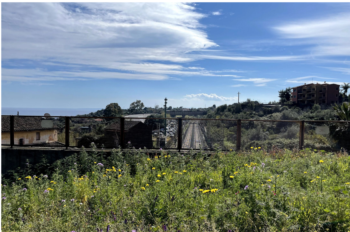
2. Foto dell'area d'intervento dalla strada sovrastante l'ingresso della galleria
