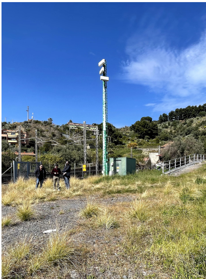
10. Vista dell'area d'intervento ad est della ferrovia
