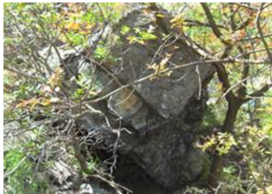
Figura n.4.3 – Blocco di distacco rilevato nel settore meridionale
