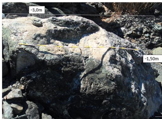
Figura n.4.4 – Blocco di distacco rilevato nel settore settentrionale
