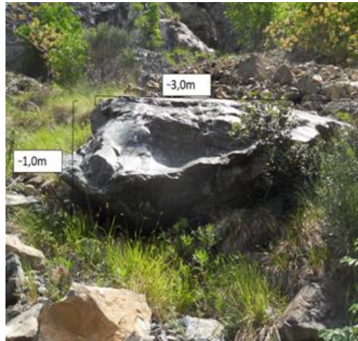
Figura n.4.2 – Blocco di distacco rilevato nel settore centrale
