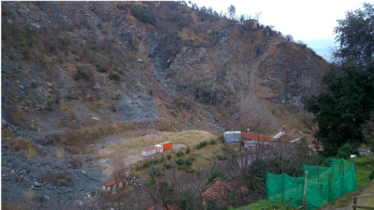
Figura n.1.1 – Vista da monte cava “Serra”
