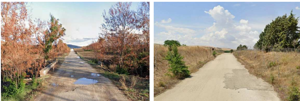
Figura 7. I sottopassi idraulici oramai fatiscanti e le buche sulla sede stradale, che vengono ad oggi chiuse alla bene meglio senza programmare interventi di ripristino integrale della sede stradale.
