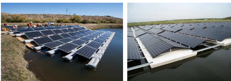
Figura 27. Esempi dei telai di galleggiamento prima citati.
