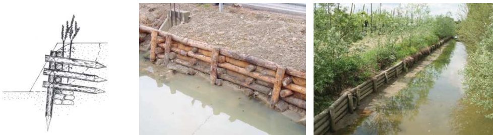
Figura 42. Esempi di palificate verdi realizzate lungo canali di bonifica.
