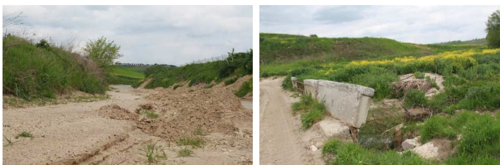
Figura 1. La SP26 invasa dal fango ed un esempio dei dissesti generati dall'alluvione 2011.
