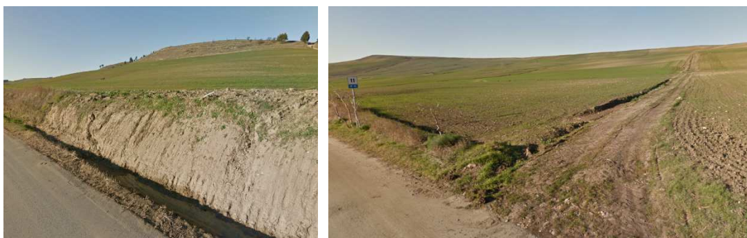
Figura 4. Le scarpate stradali non sono stabilizzate, le canalette di drenaggio laterali risultano spesso ostruite, non esistono sistemi di collettamento dei ruscellamenti superficiali che drenano i campi coltivati a monte della strada.
