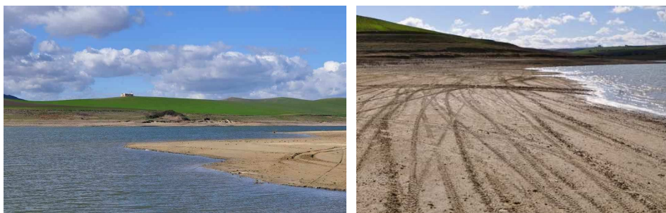
Figura 28. Gli estesi depositi di materiale solido all'interno del lago hanno causato una netta riduzione del volume utile di invaso.
