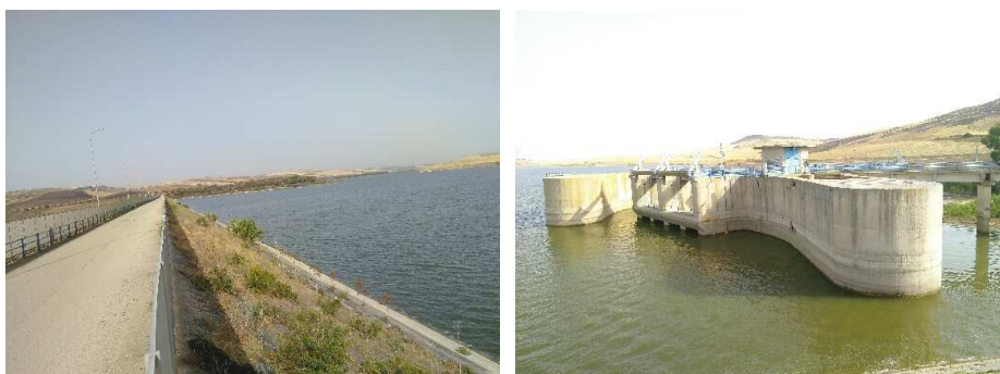
Figura 33. Il paramento di monte dello sbarramento della diga e organi di presa e sfioro presso l'invaso di Serra del Corvo a maggio 2022.
