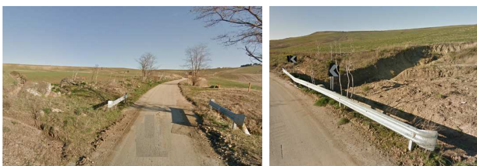
Figura 5. I vari sottopassi esistenti non sono in uno stato funzionale buono. I solchi erosivi non sono sistemati e ad ogni pioggia acqua a fango si riversano sulla sede stradale.
