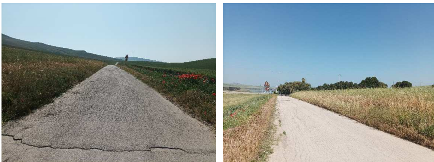
Figura 3. La SP26 nei pressi della diga del Basentello.
