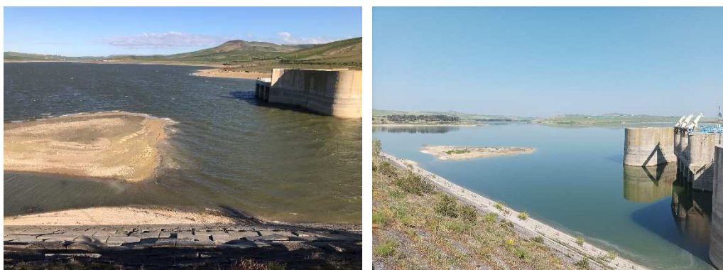
Figura 29. Gli evidenti depositi di materiale nei pressi dell'opera di presa di EIPLI nei pressi del paramento di monte della diga del Basentello.
