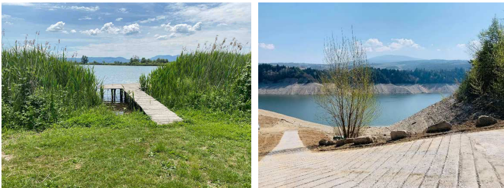
Figura 20. Esempi di accessi strutturati, pedonali e carrabile, alle sponde del lago di Serra del Corvo.
