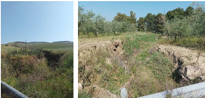
Figura 45. Altre due immagini (maggio 2022) del fossato non regimato che degrada dai versanti in erosione nei pressi della diga di Serra del Corvo.
