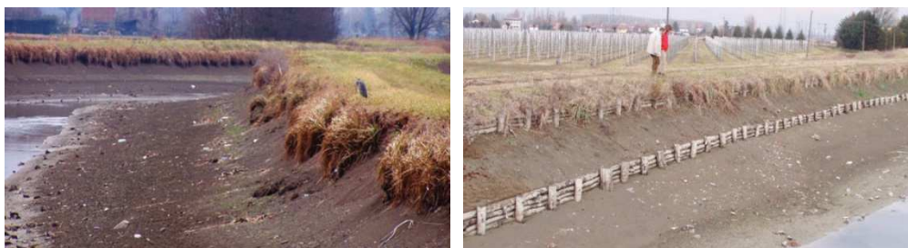
Figura 43. Stabilizzazioni di sponda con palificate verdi.
