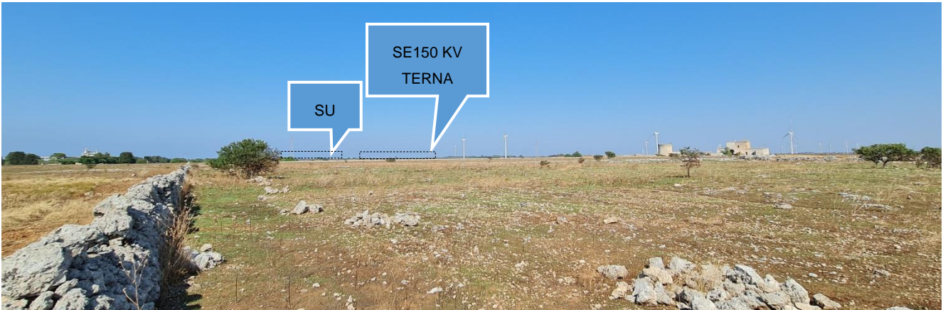
Figura 16-13: Vista da P3 – Post operam
