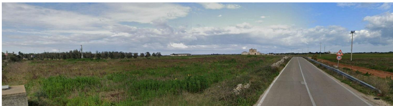
Figura 16-5: Vista da P1 – Ante operam
