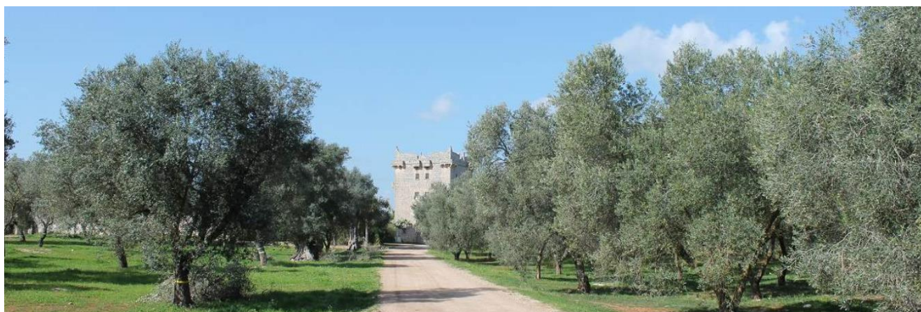
Figura 16-6: Vista da P2 – Ante operam
