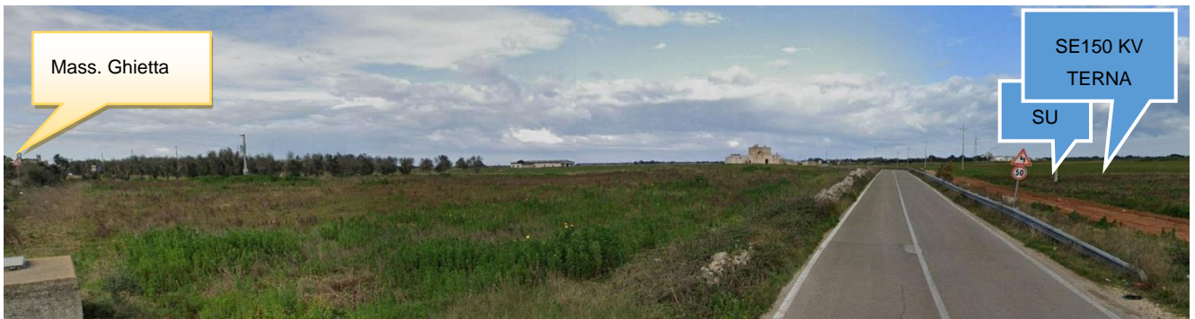
Figura 16-11: Vista da P1 – Post operam
