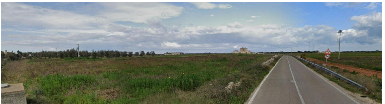
Figura 6-3: Vista da P1 – Ante operam
