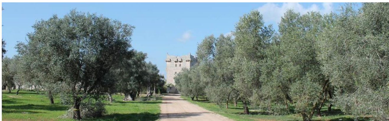
Figura 6-4: Vista da P2 – Ante operam
