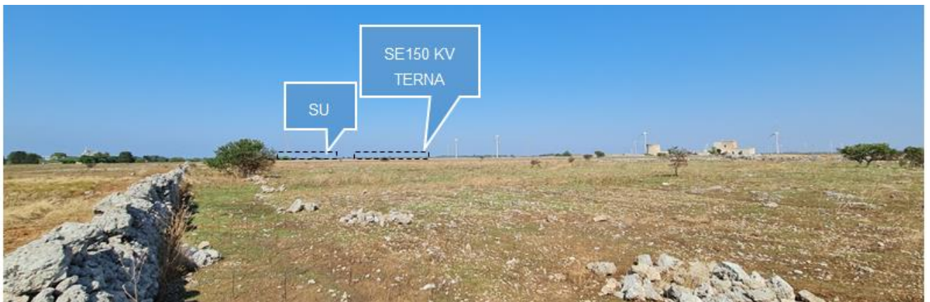
Figura 6-11: Vista da P3 – Post operam
