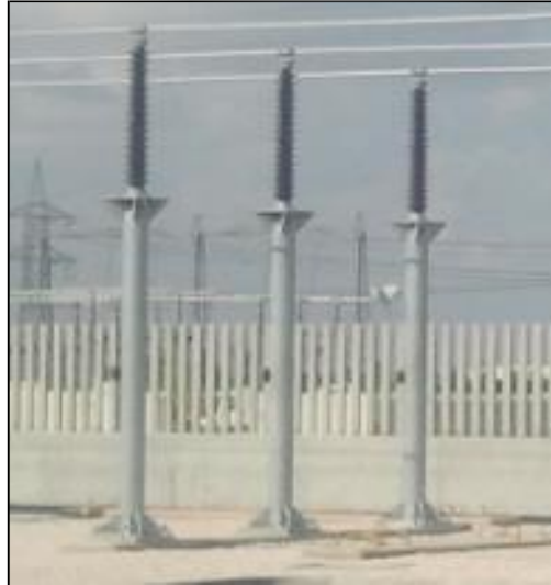
Figura 9.16. Particolare in foto dei supporti
