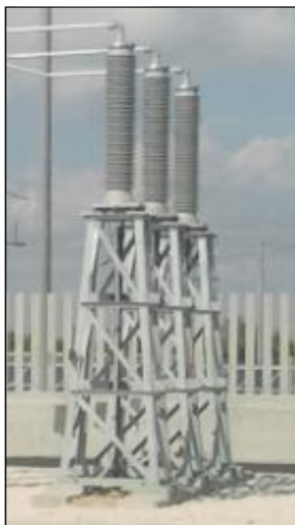
Figura 9.6. Terminale cavo AT Tipo.
