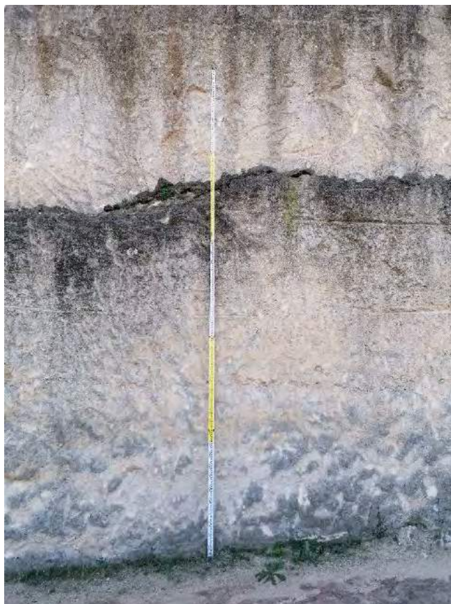
Figura 1 – Parete interessata dal rilievo geomeccanico
