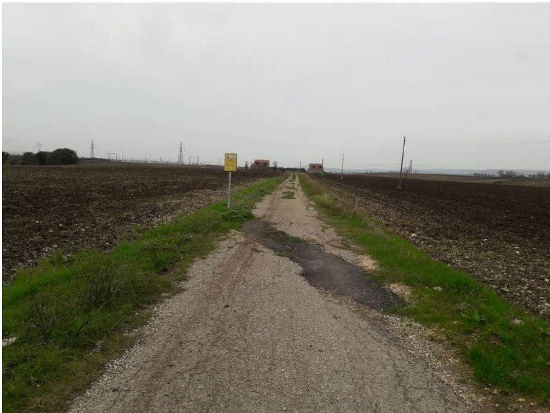
Rotello, loc. Piano della Fontana, la strada Contrada Fontedonico che attraversa longitudinalmente l'altura, vista da SO
