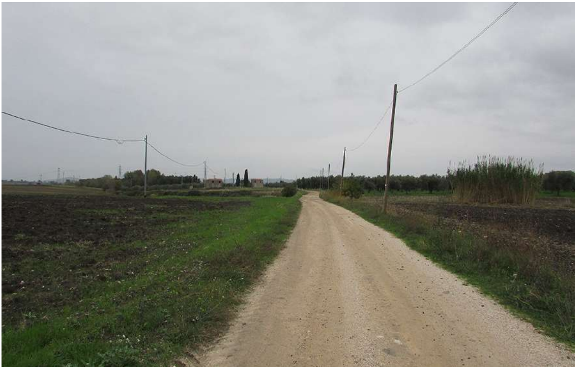
76 - Rotello (CB) Piano Palazzo, UR 4 panoramica del segmento del cavidotto di collegamento corrente su strada Piano Palazzo in direzione NE
