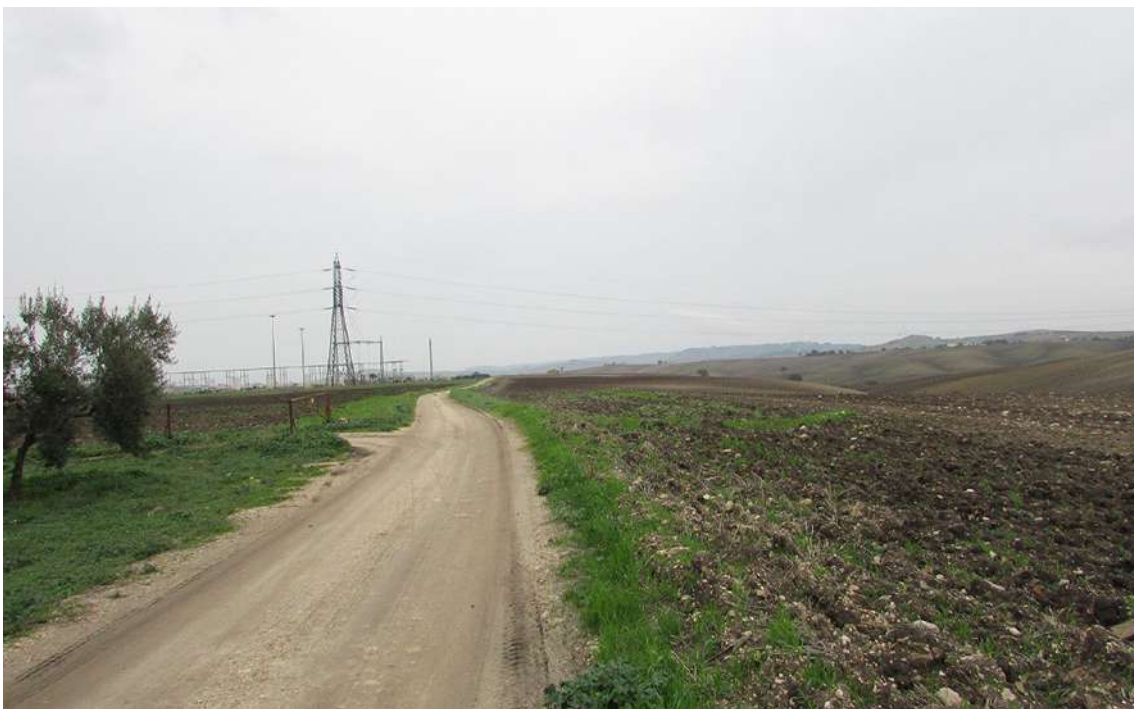
34 - Rotello (CB) loc. Piano della Fontana, UR 2 cavidotto di collegamento dai campo 5-6 in direzione N, corrente su strada Fontedonico
