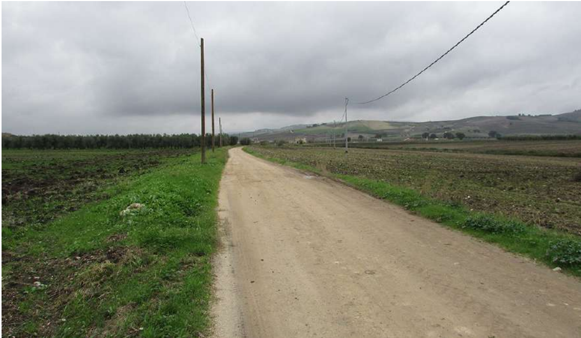
77 - Rotello (CB) Piano Palazzo, UR 4 panoramica del segmento del cavidotto di collegamento corrente su strada Piano Palazzo in direzione SO
