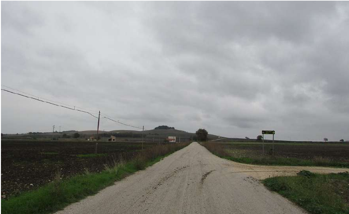
71 - Rotello (CB) Strada comunale Piano Palazzo, UR 4 panoramica del segmento del cavidotto di collegamento corrente su s.c. Piano Palazzo verso incrocio con strada Verticchio in direzione E
