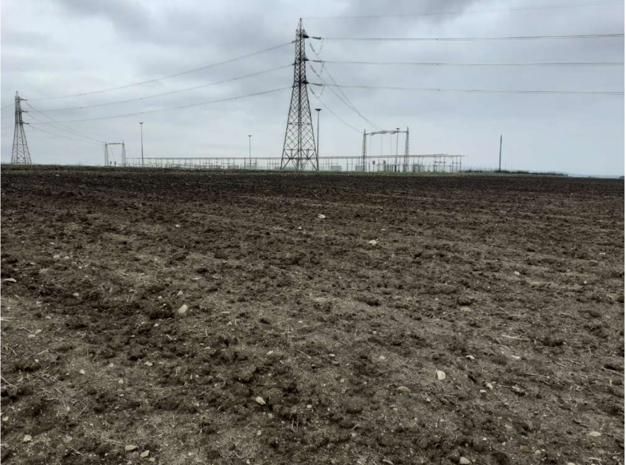
UR 2; angolo NE del campo 6; sullo sfondo la Stazione Elettrica Terna
