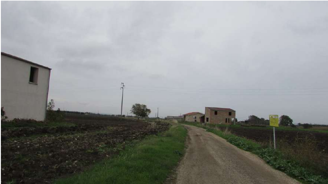
69 - Rotello (CB) c.da Verticchio, UR 4 panoramica del segmento di cavidotto di collegamento corrente su strada Verticchio in direzione N, all'incrocio con Strada comunale Piano Palazzo
