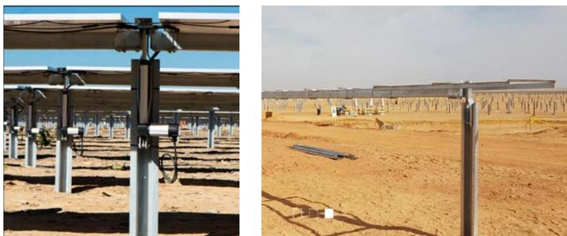
Figura 8- Particolare strutture ad inseguimento ed attuatore
