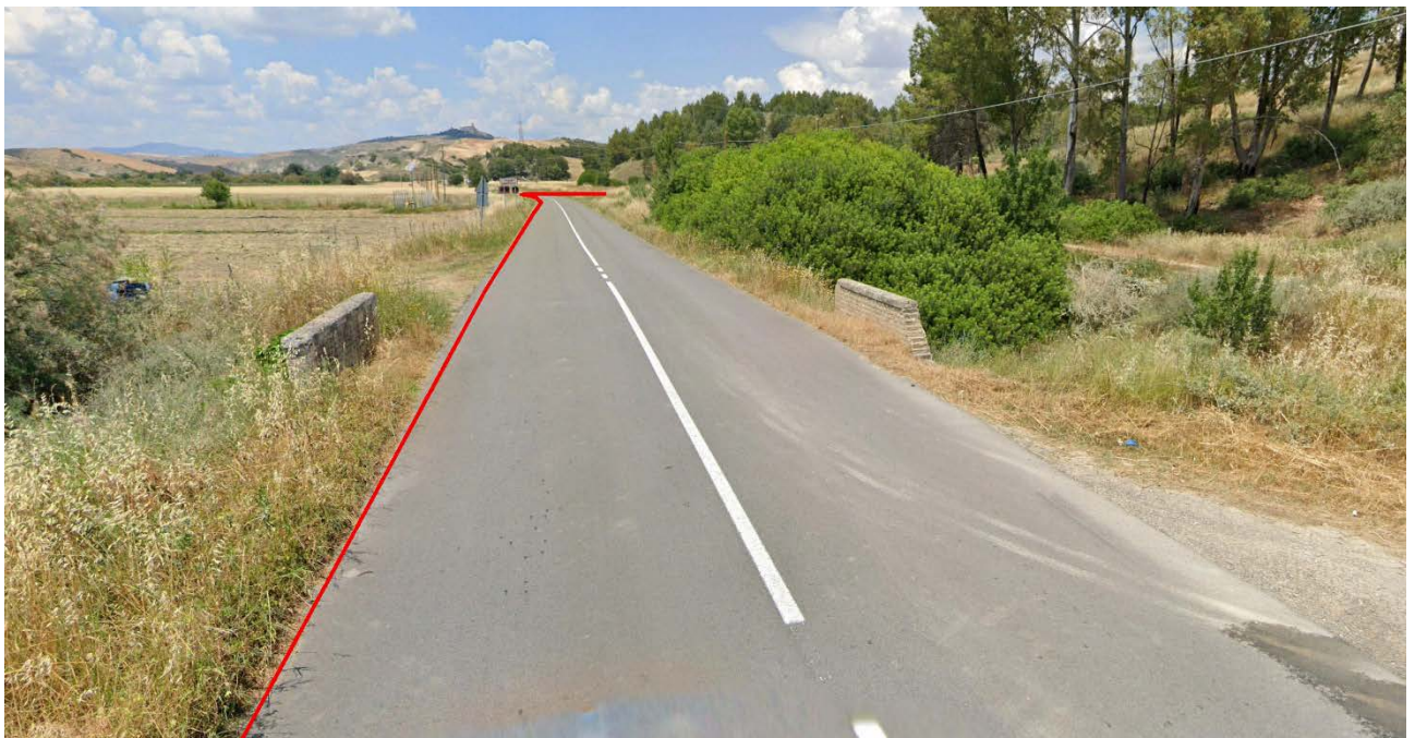
Figura 13 –Secondo ponte sul fosso Pescara (SP103)
