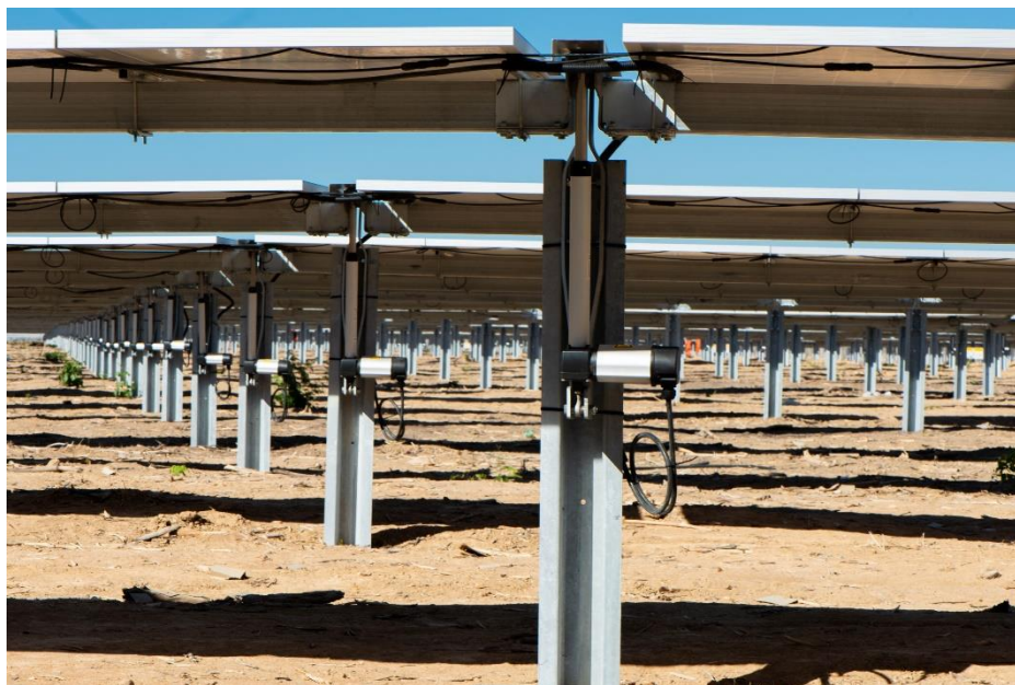
Fig. 5 - Palo del tracker infisso nel terreno
