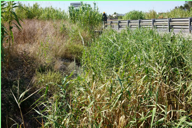
Figura 29: Canale (Punto rilievo: 28).
