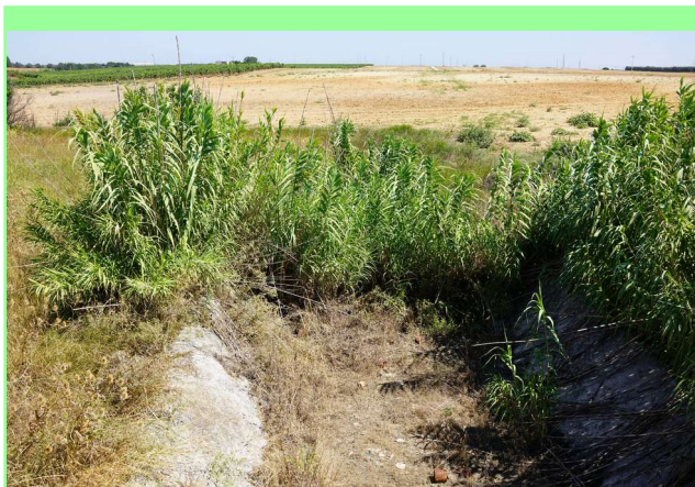
Figura 33: Canale (Punto rilievo: 10).
