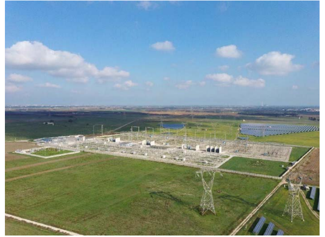
Foto 4 aree Sottostazione Elettrica Utente
