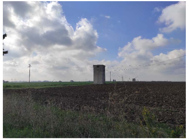
Foto 2 - aree impianto Fotovoltaico
