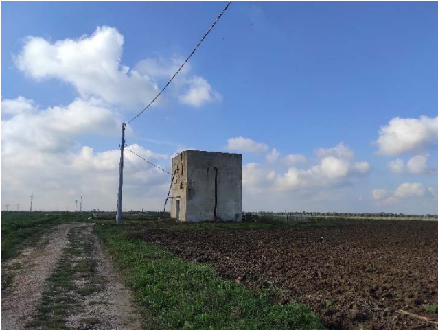
Foto 3 - aree impianto Fotovoltaico
