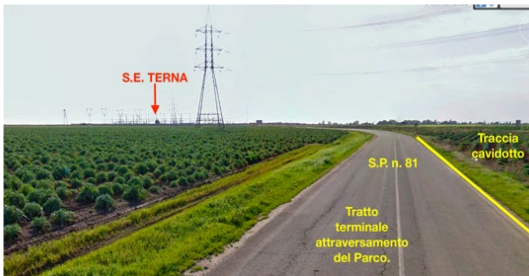
Foto n. 5: vista da S.P. 81 verso NW- tratto terminale (SP81) di attraversamento Parco
