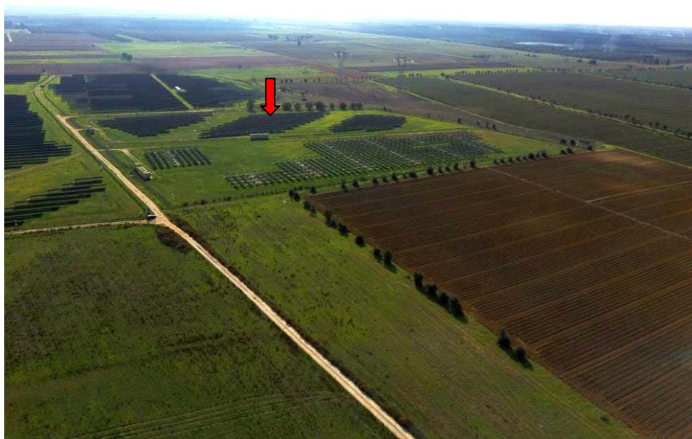
Foto da drone
