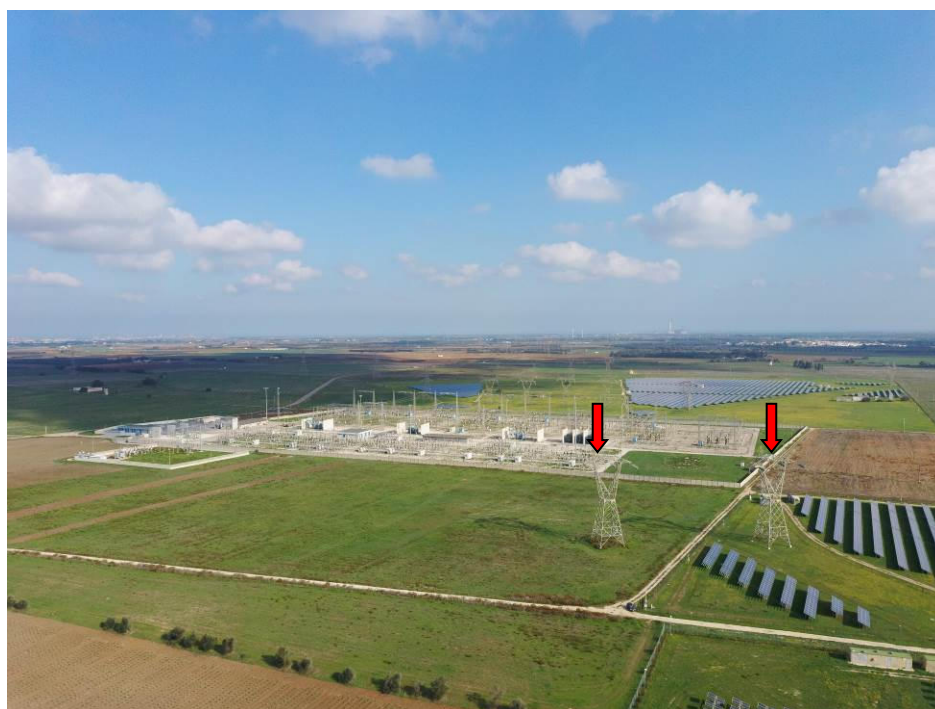
Foto da drone
