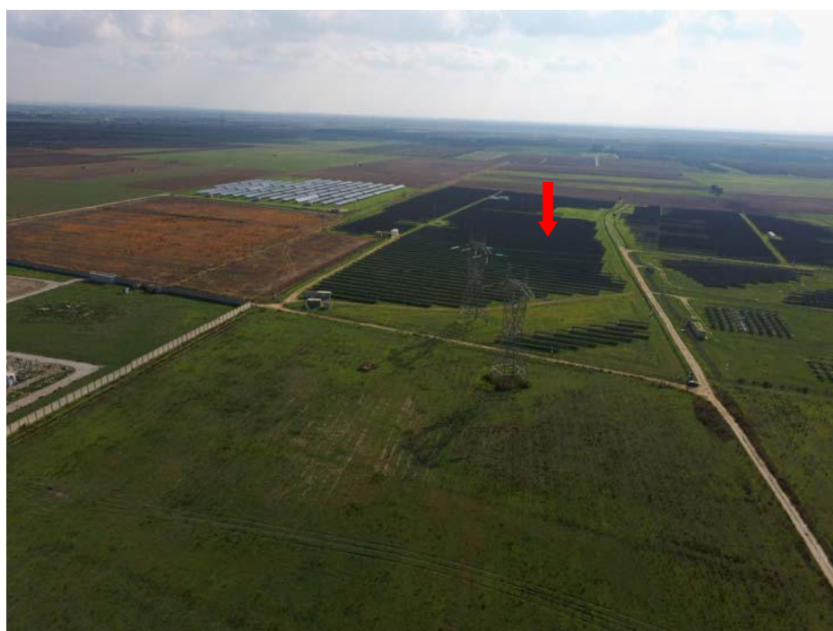
Foto da drone
