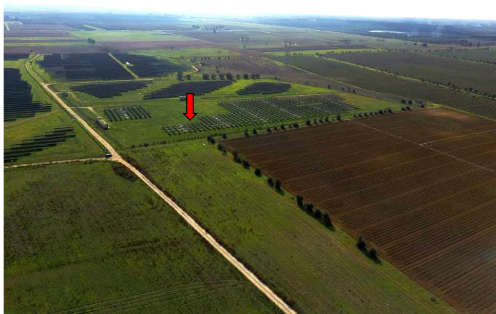
Foto da drone
