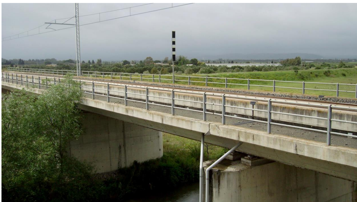
Figura 49 Viadotto ante operam e post operam
