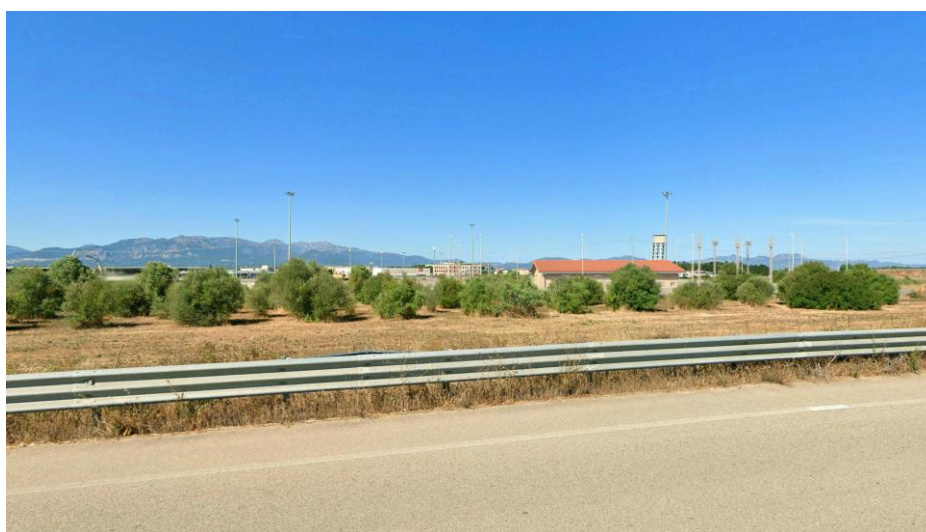
Figura 48 SSE di San Gavino ante operam e post operam
