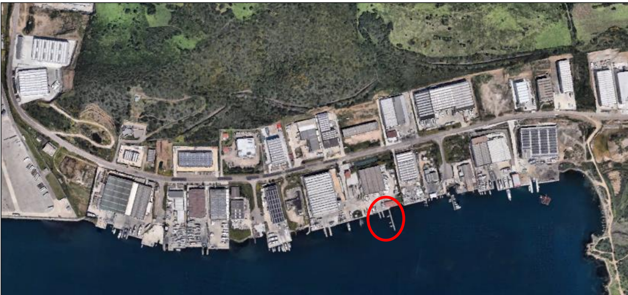
Figura 8 Inquadramento della zona con marcata vocazione cantieristica
