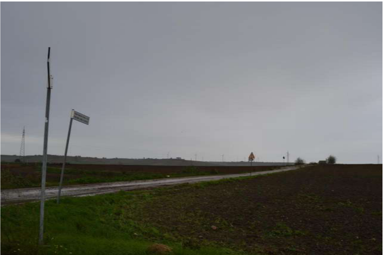
Cavidotto di collegamento alla stazione elettrica
