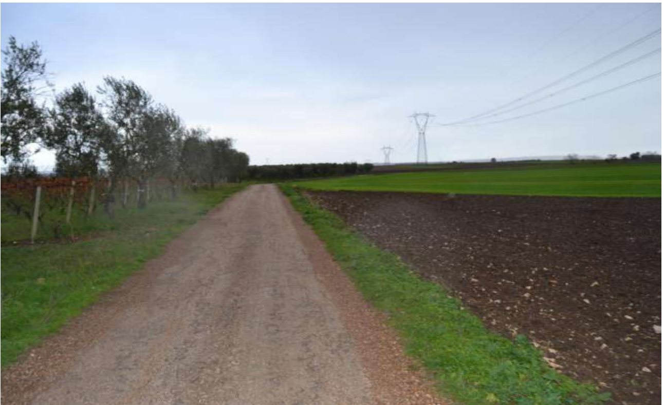
Cavidotto di collegamento alla stazione elettrica
