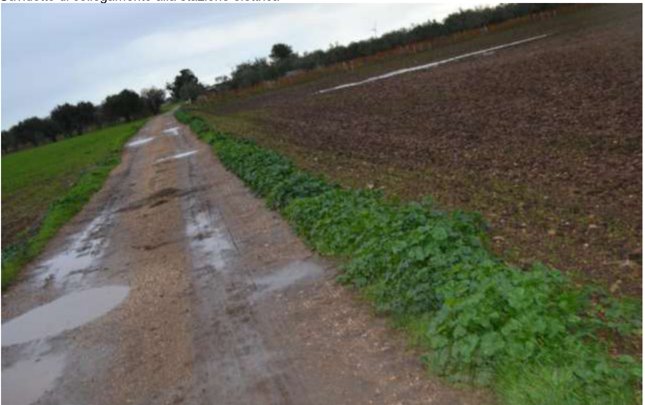
Cavidotto di collegamento alla stazione elettrica
