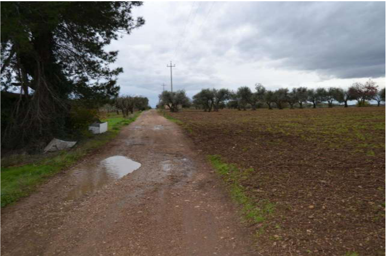
Cavidotto di collegamento GR 3-1
