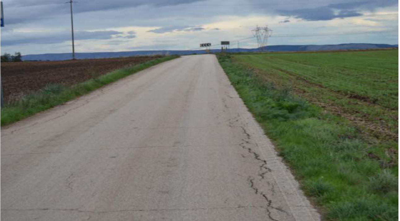
Cavidotto di collegamento GR 3-1
