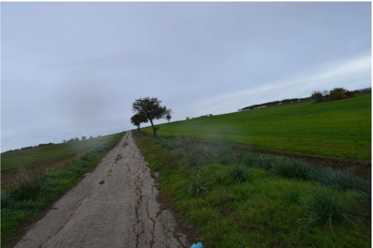
Cavidotto di collegamento alla stazione elettrica
