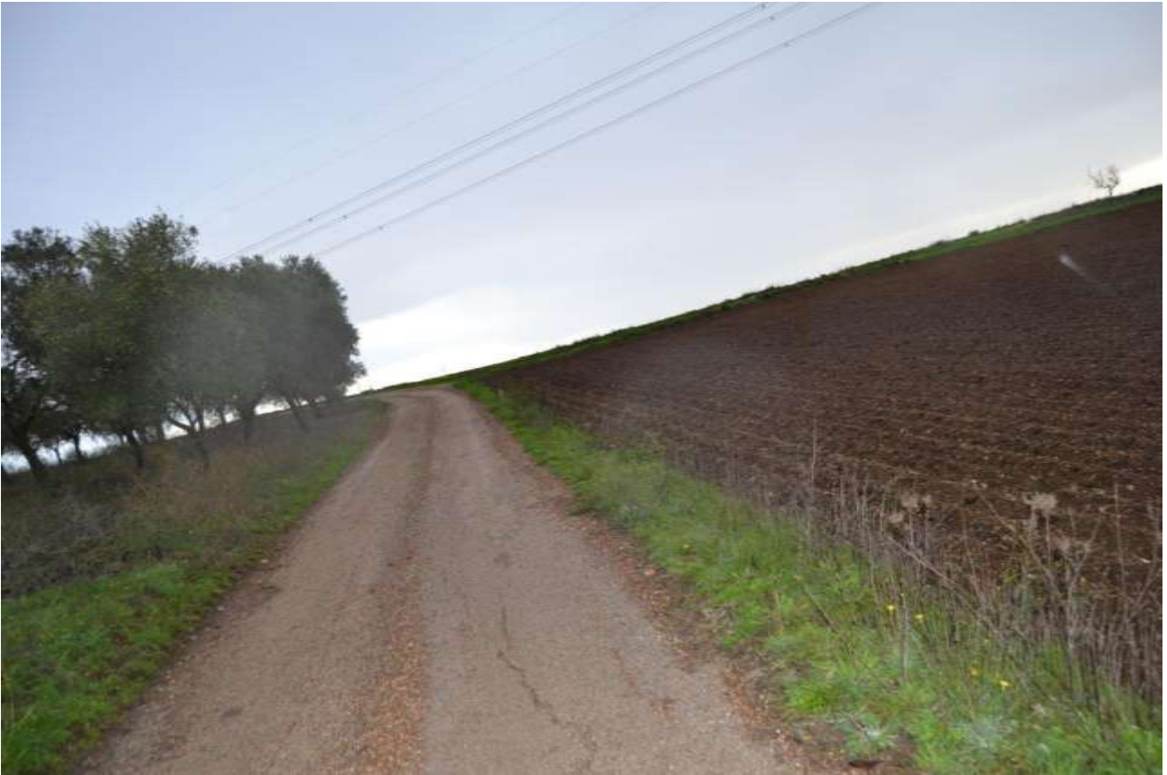
Cavidotto di collegamento alla stazione elettrica
