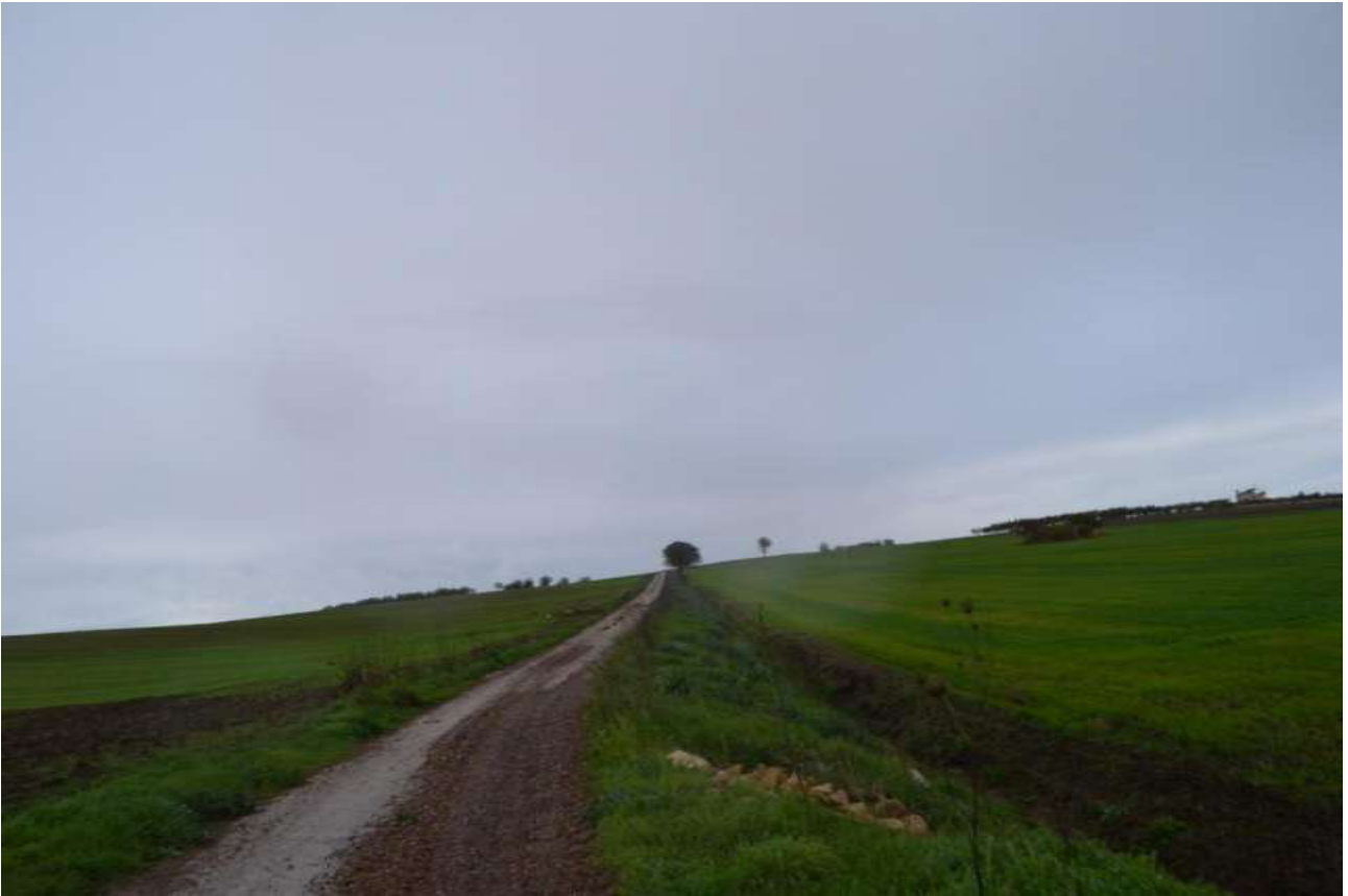
Cavidotto di collegamento alla stazione elettrica
