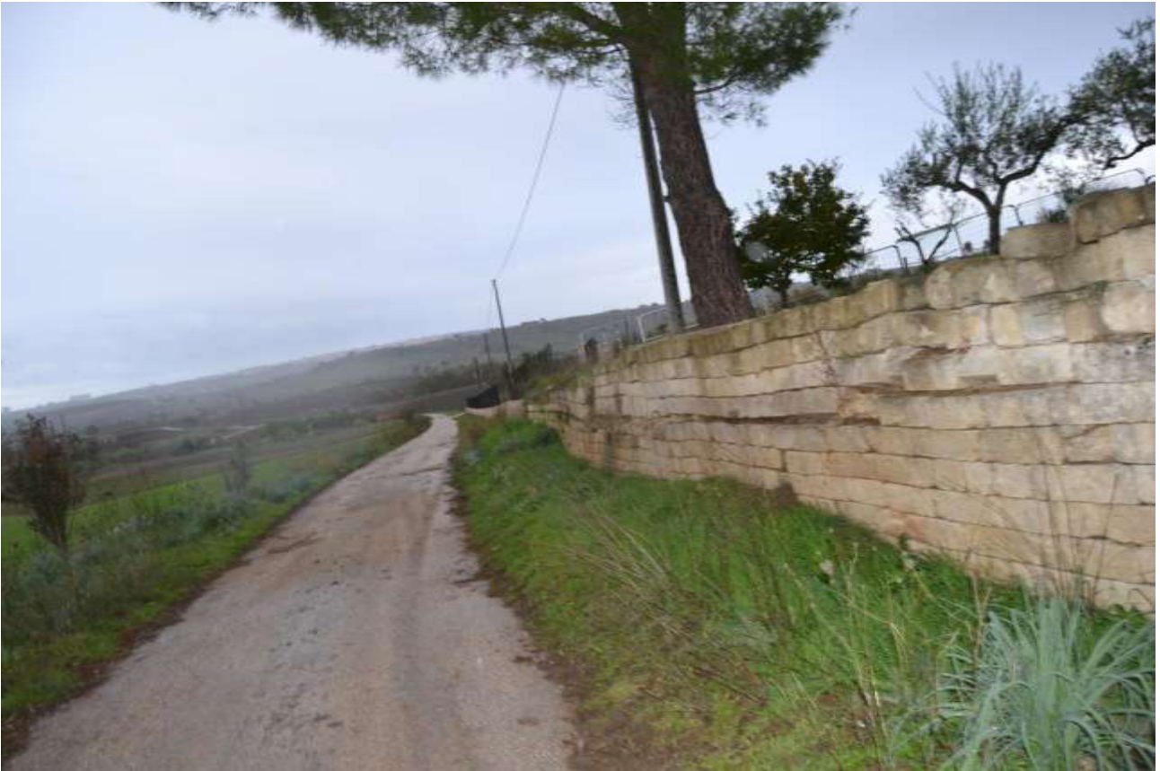
Cavidotto di collegamento alla stazione elettrica
