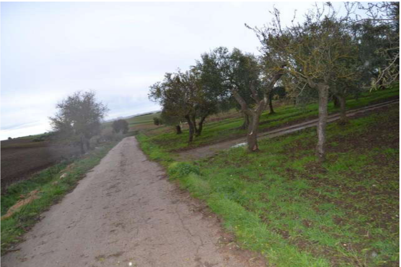
Cavidotto di collegamento alla stazione elettrica
