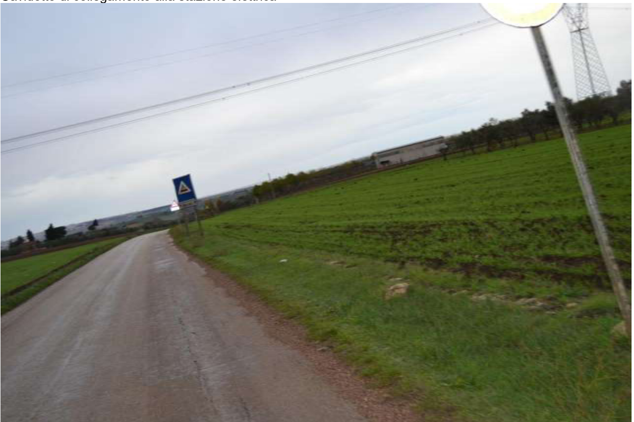
Cavidotto di collegamento alla stazione elettrica
