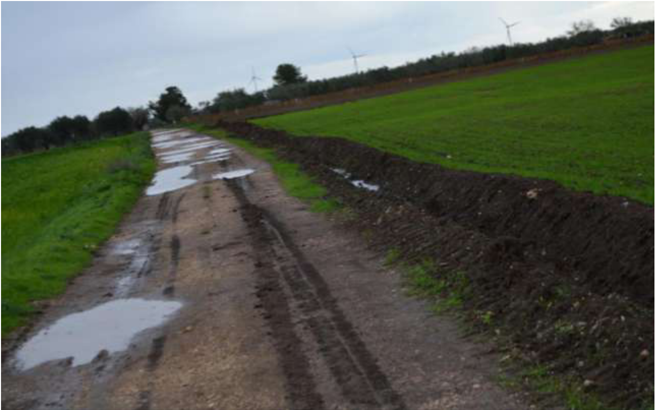
Cavidotto di collegamento alla stazione elettrica
