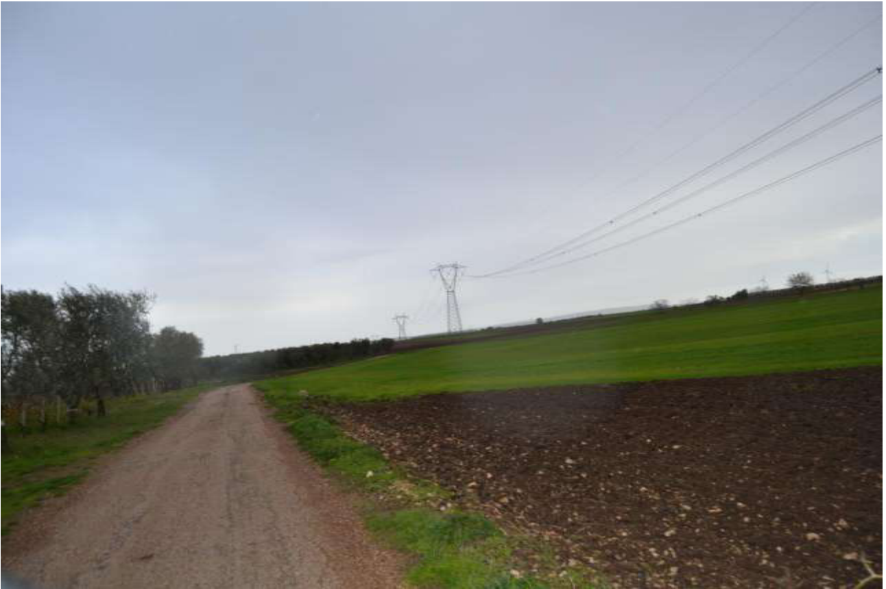
Cavidotto di collegamento alla stazione elettrica
