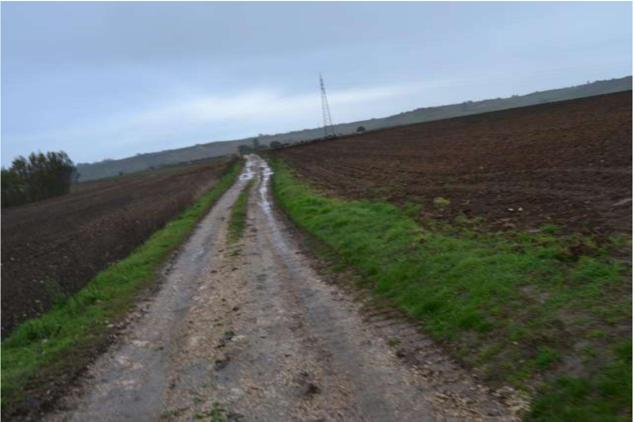
Cavidotto di collegamento alla stazione elettrica
