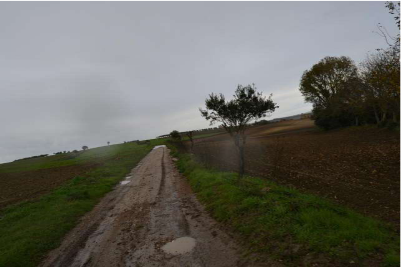
Cavidotto di collegamento alla stazione elettrica
