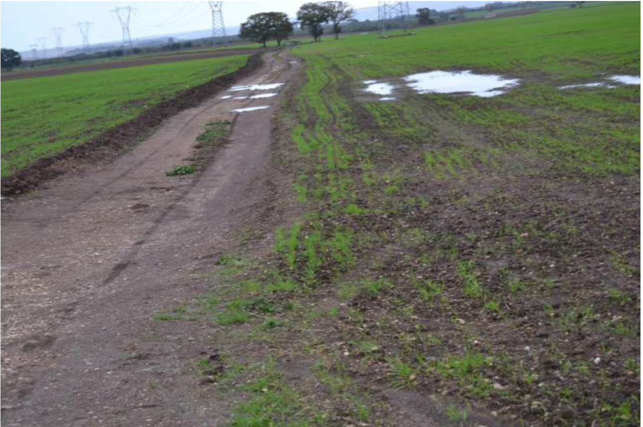
Cavidotto di collegamento GR 3-Gr 4
