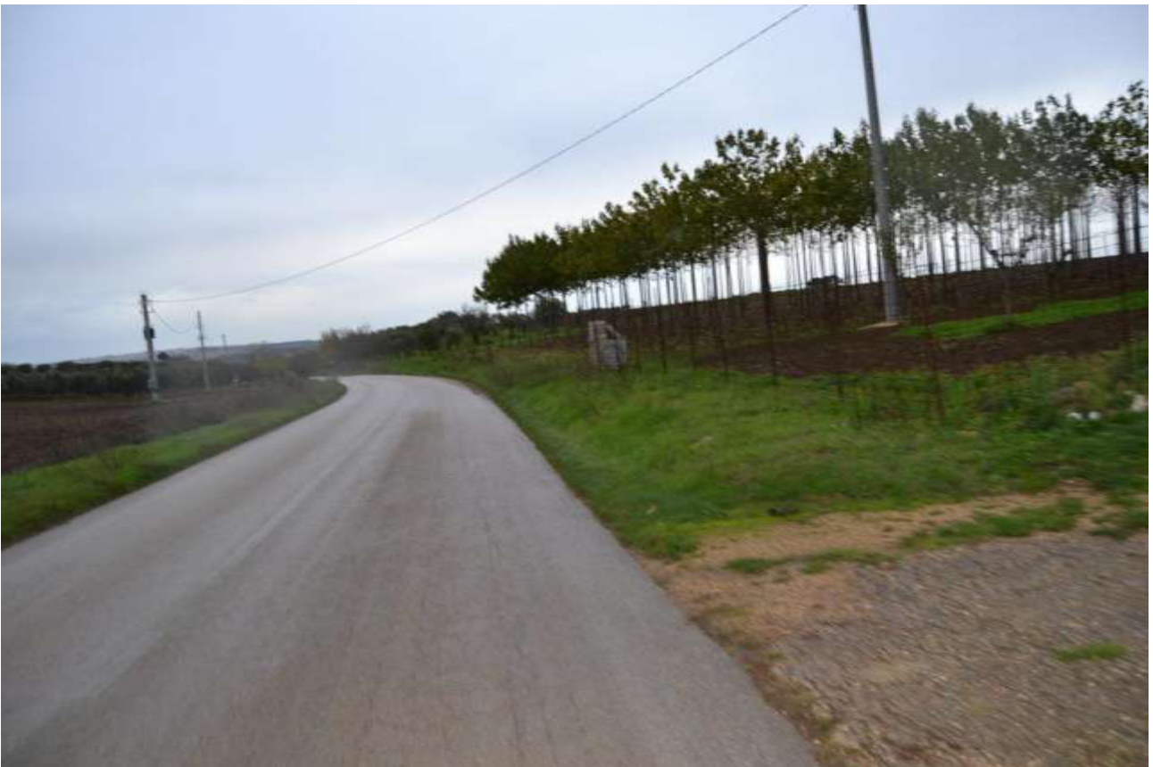
Cavidotto di collegamento alla stazione elettrica
