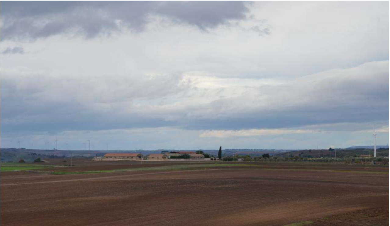
Area della messa in opera dell'aerogeneratore
