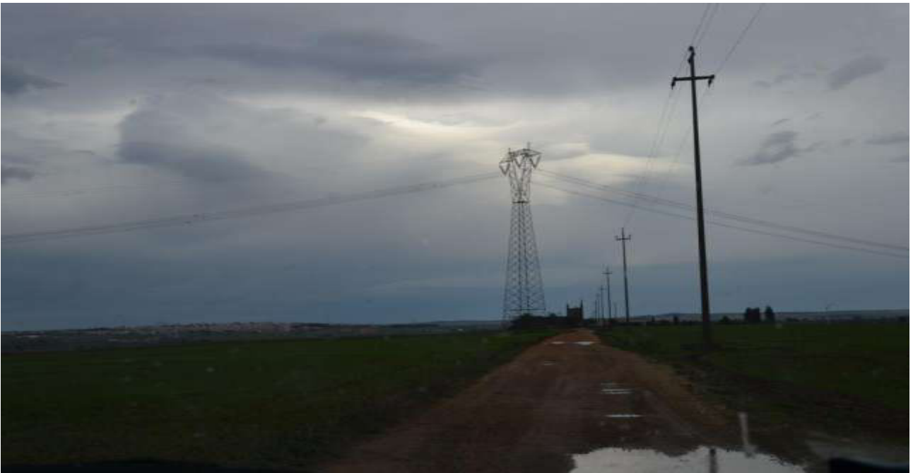
Cavidotto di collegamento GR 3-1
