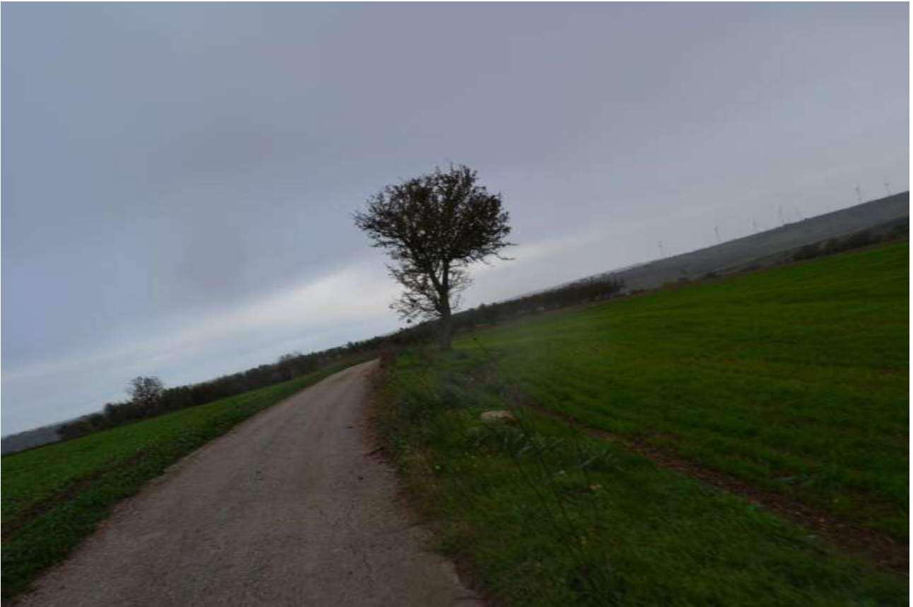
Cavidotto di collegamento alla stazione elettrica
