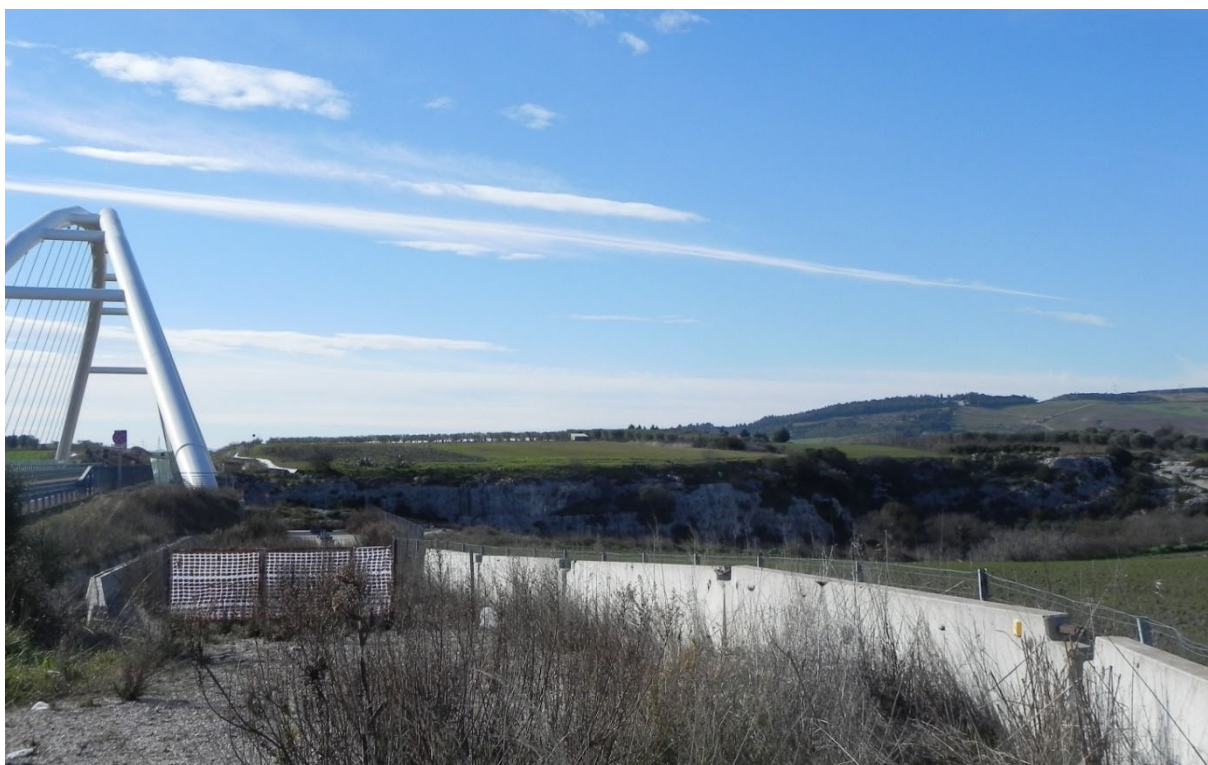
Figura 14: Pdl 23: SS655 Ponte ad arco sul Torrente Gravina - Parco archeologico storico-naturale delle Chiese rupestri del Materano
