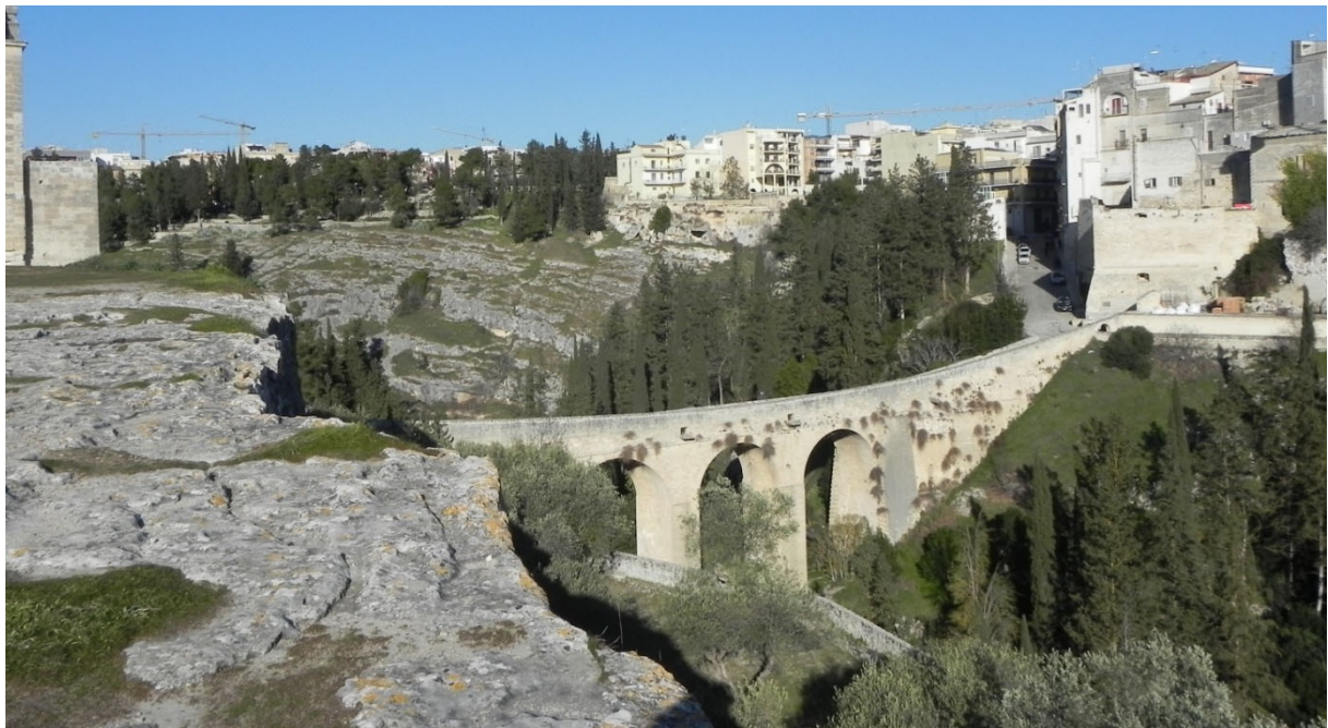
Figura 6: Pdl 1: Ponte acquedotto La Gravina
