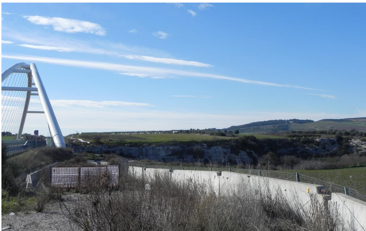
Figura 43. Pdl 23: SS655 Ponte ad arco sul Torrente Gravina - Parco archeologico storico-naturale delle Chiese rupestri del Materano
