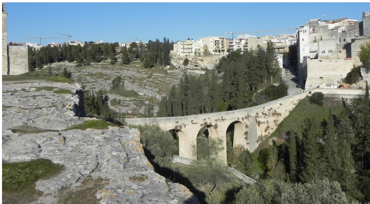
Figura 35. Pdl 1: Ponte acquedotto La Gravina
