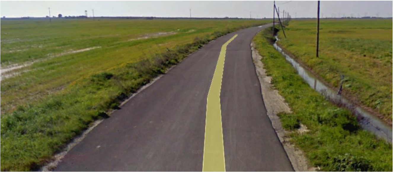
Figura 3-11: strada comunale n.32
