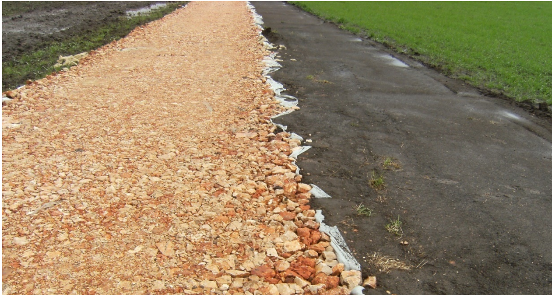
Dettaglio pacchetto stradale con geotessuto
