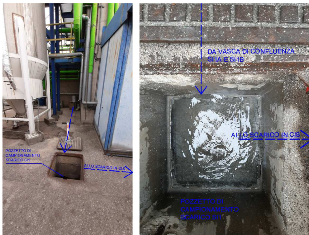
Figura 2 – Pozzetto campionamento SI1 con evidenza dei percorsi delle linee interrante.
