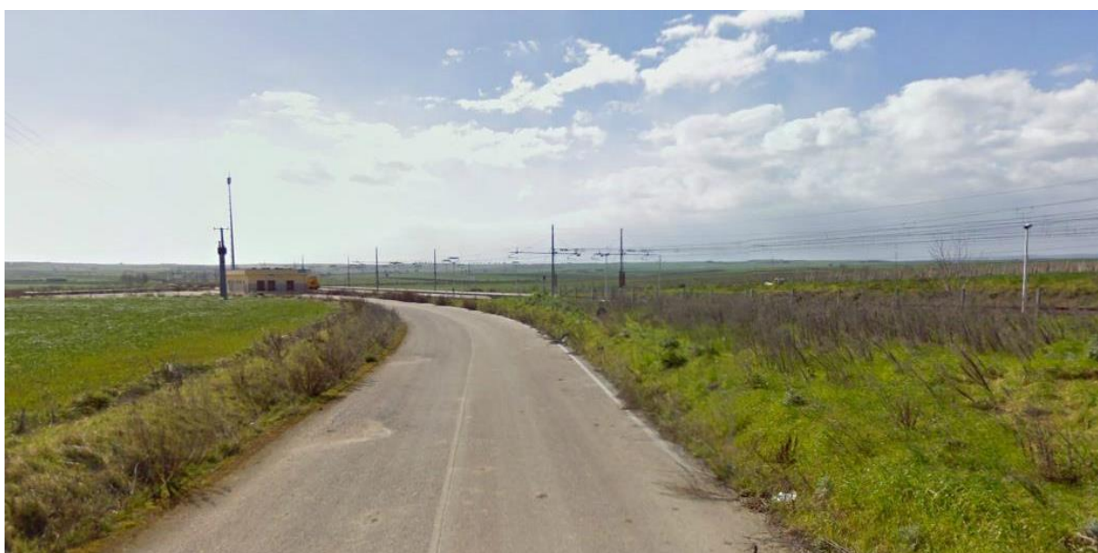
Strada di accesso al PM di Lesina e al cantiere di armamento CA1.1
