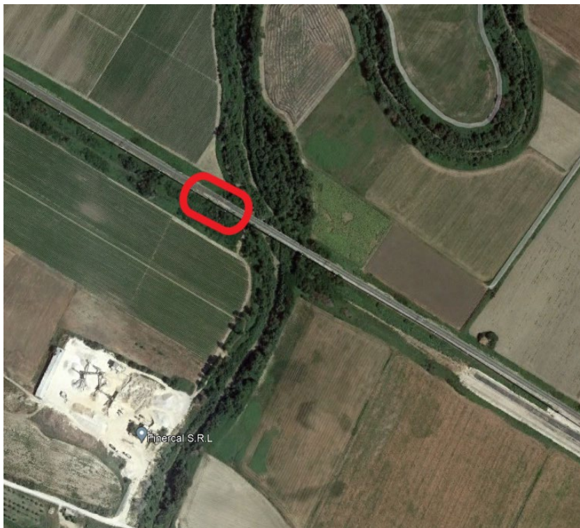
Figura 8 – Vista aerea dell'area di intervento tombini di trasparenza sponda sx fiume Fortore
