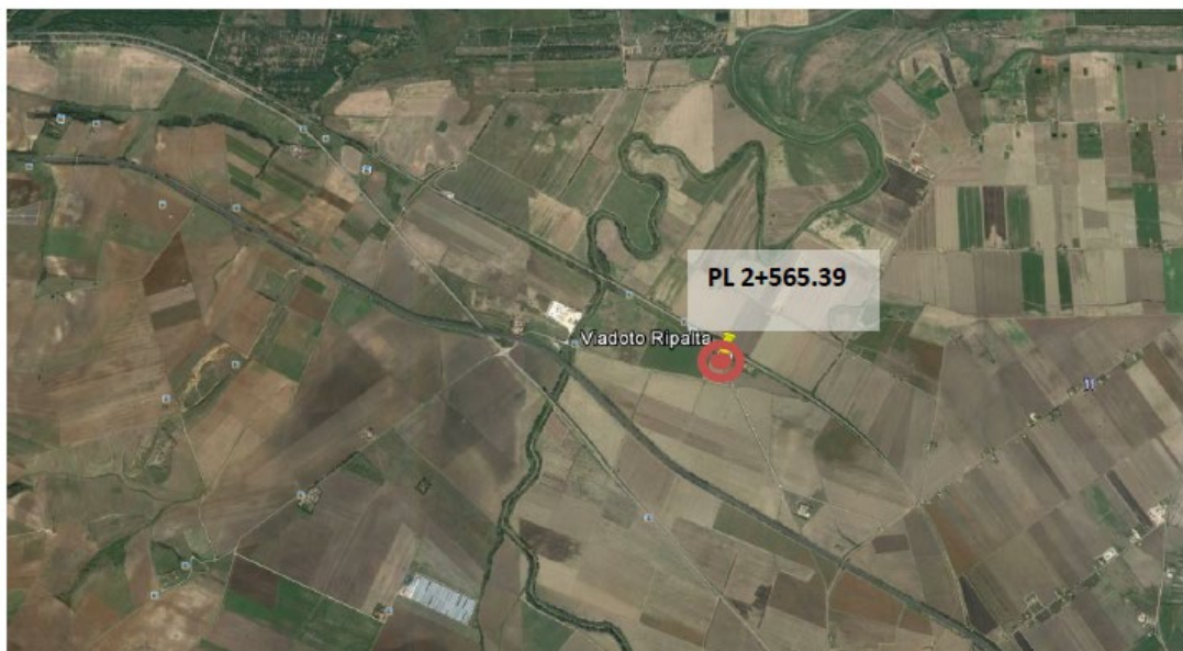
Figura 2 – Vista aerea dell’area di intervento del viadotto VI01
