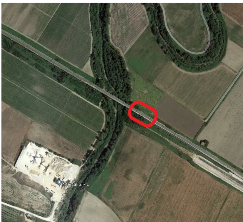
Figura 9 Vista aerea dell'area di intervento tombini di trasparenza sponda dx fiume Fortore
