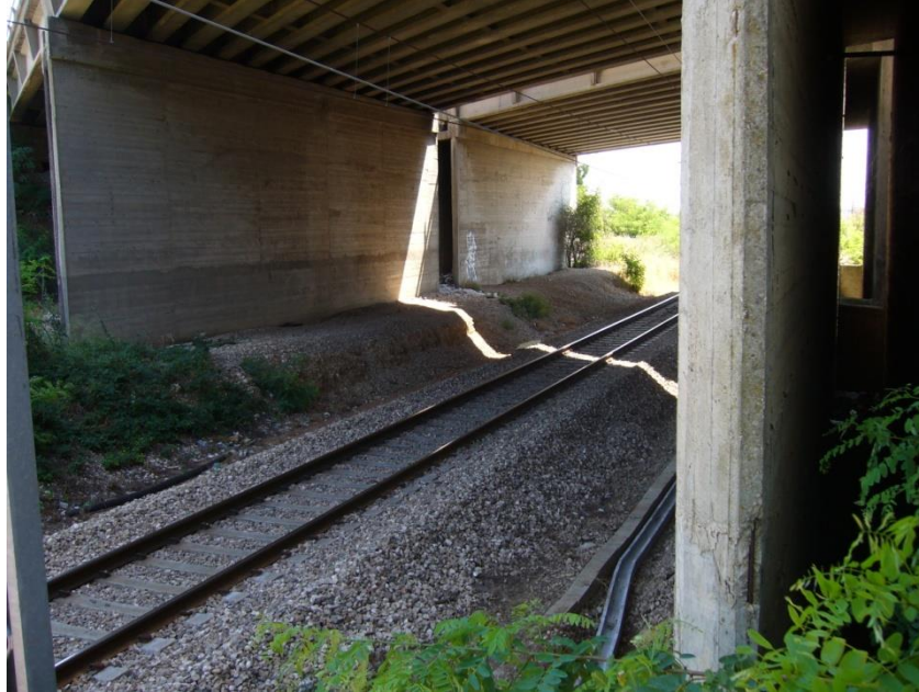
Figura 3-2 – CVF Autostrada A14.
