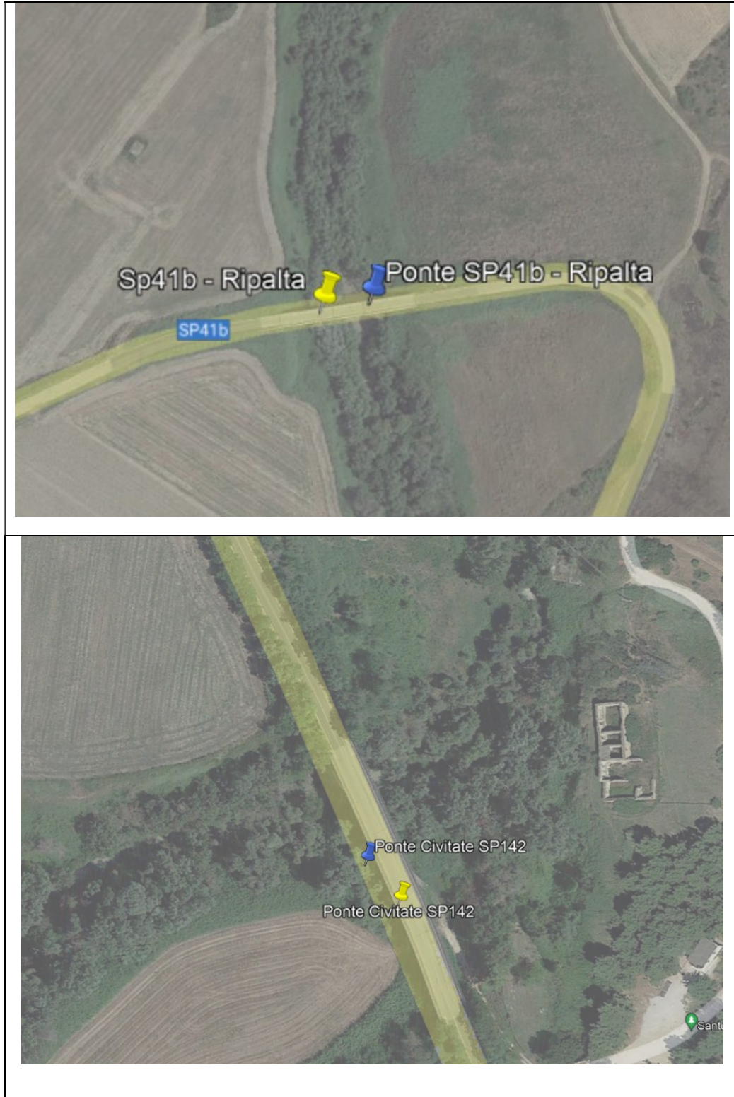
Figura 8-13 - Ortofoto con identificazione del ponte
