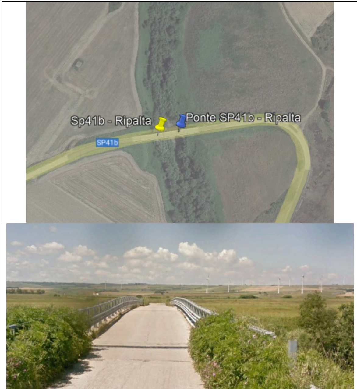
Figura 8-9 PLUV.1 Ponte Sp41b - Ripalta (n.1 pluviometro + n.1 idrometro) 41°51'35.05"N 15°16'0.66"E:
