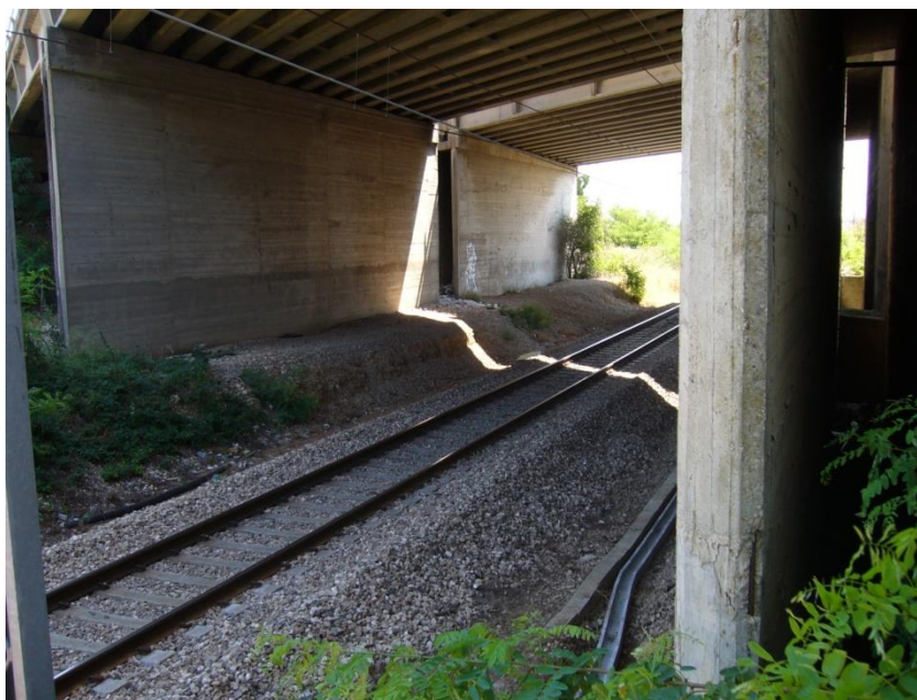
Figura 2. Cavalcaferrovia esistente Autostrada A14
