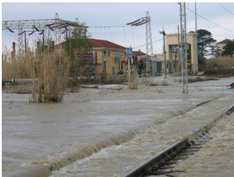
Figura 1. Vista fotografica dell'ex stazione di Ripalta durante l'esondazione del Fortore (in basso a destra il binario sormontato dall'acqua)
