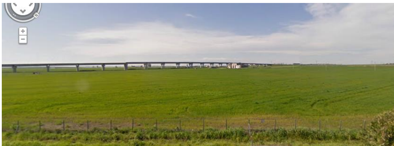
Figura 3. Vista della bretella di collegamento SS16 – SP37
