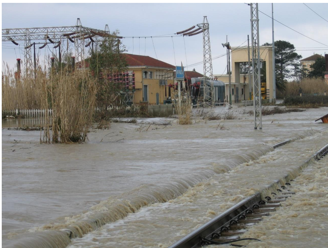
Figura 1 – Allagamento SSE Ripalta
