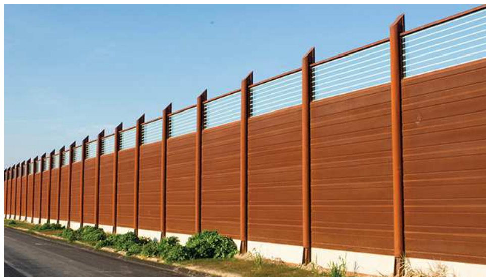
Fig. 12.1 – Tipologico barriera acustica mista in acciaio corten e vetro temperato
