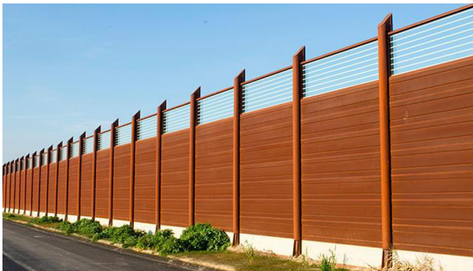
Tipologico barriera acustica mista in acciaio corten e vetro temperato
