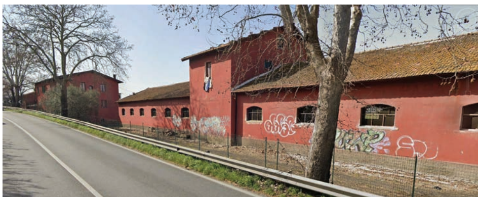
Figura 14 Fabbricato lineare lungo la via Salaria (Tpr-0509)
