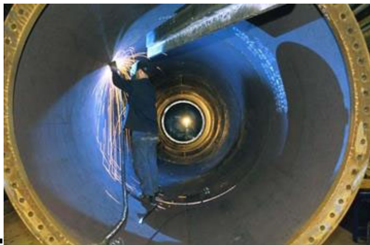
Figura 10: interno di una torre
