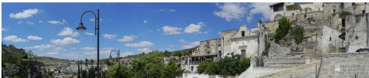
Figura 37: Stato dei luoghi in corrispondenza del punto di ripresa fotografica L (Chiesa- Grotta di S. Michele/Cripta di S. Mario - Centro abitato - Gravina in Puglia)
