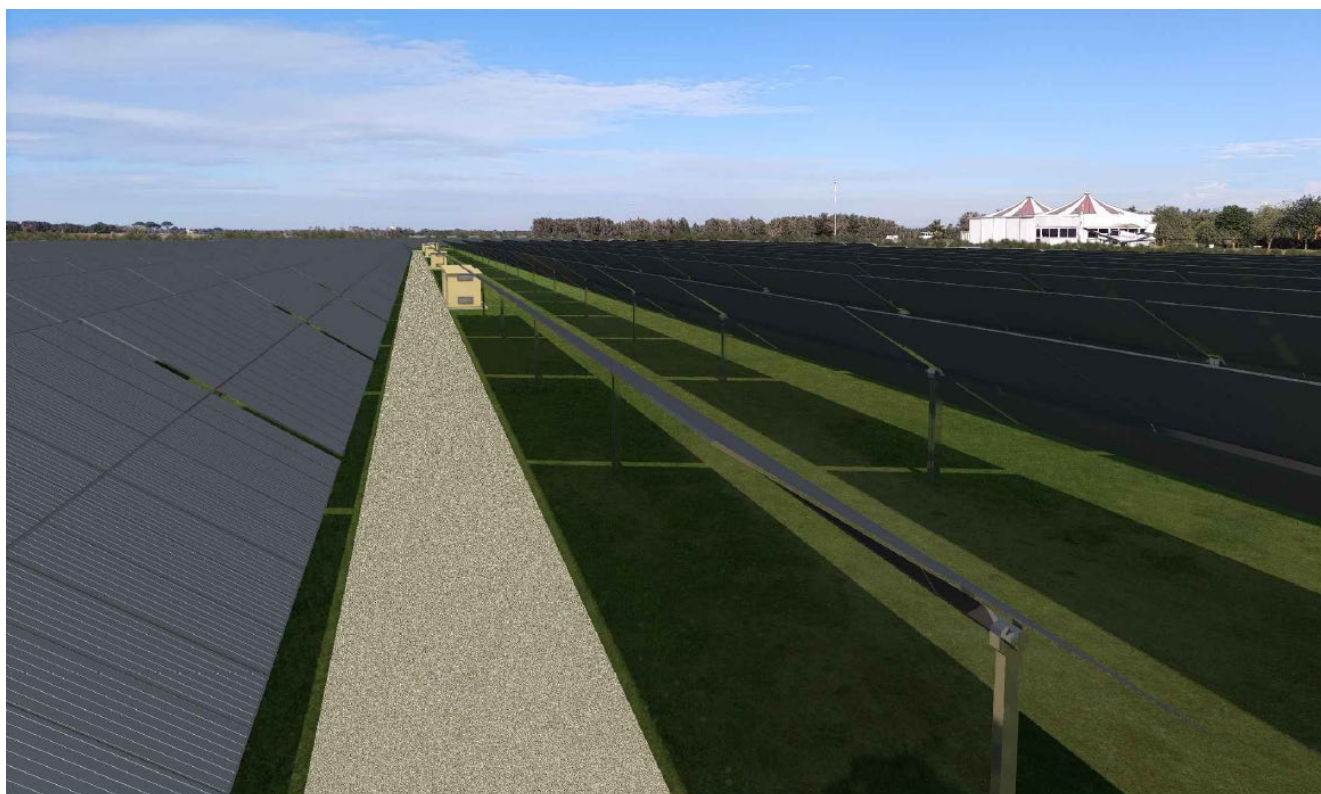
Figura 2-29: panoramica post opera dal punto di osservazione 2
