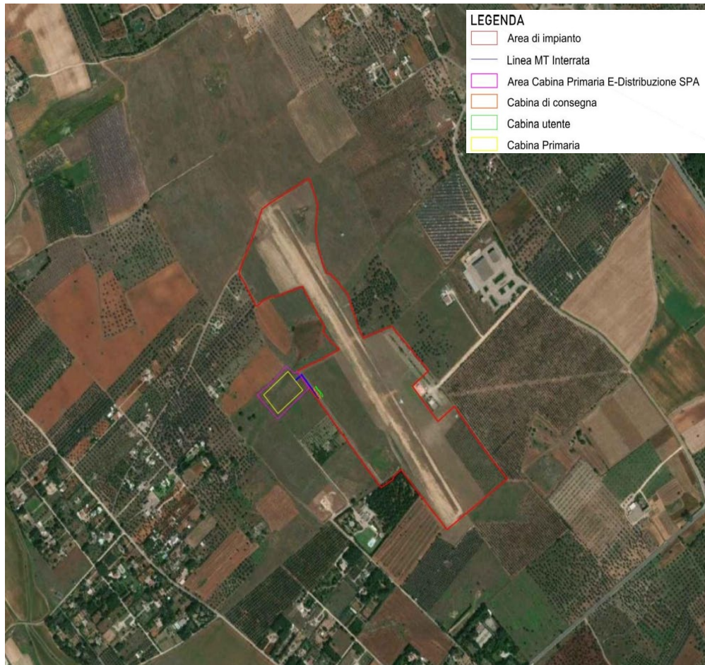
Figura 2-18: Ortofoto con vista dell'impianto fotovoltaico
