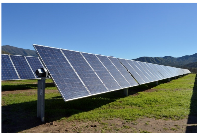
Vista di una struttura di sostegno in configurazione 1v30 portrait
