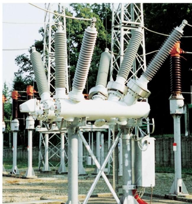
Rappresentazione di un modulo Ibrido in configurazione per singola sbarra
