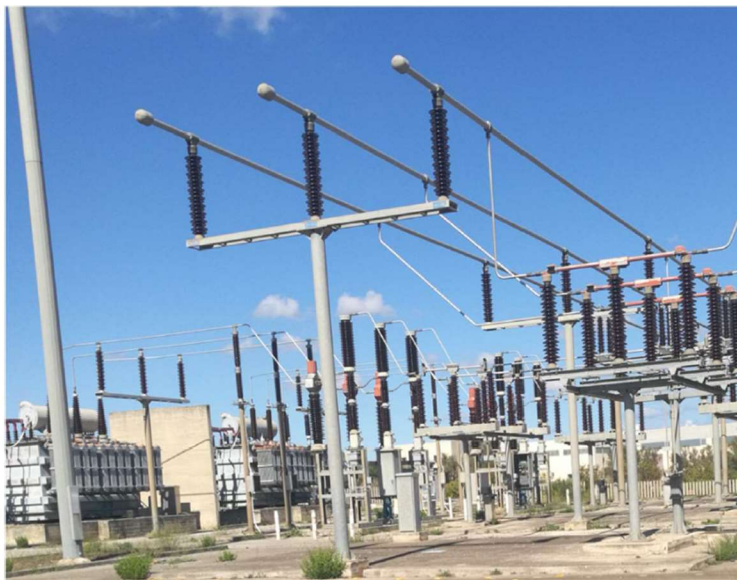
Tipico Sistema di Sbarre parallelo
