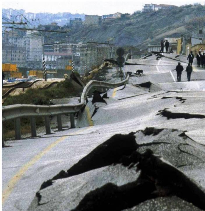
Figura 3: La ferrovia e la strada costiera divelte
