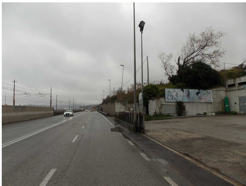
Figura 27: la Via Flaminia, da ovest, con il muro di contenimento a destra.
