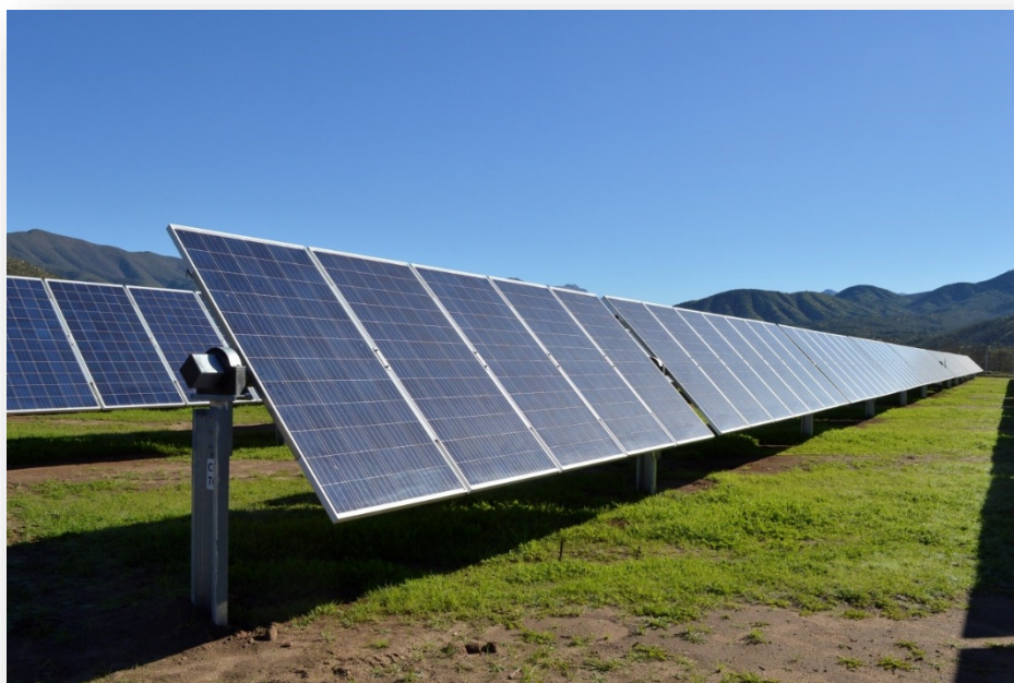
Figura 1 – Vista prospettica inseguitore solare monoassiale
