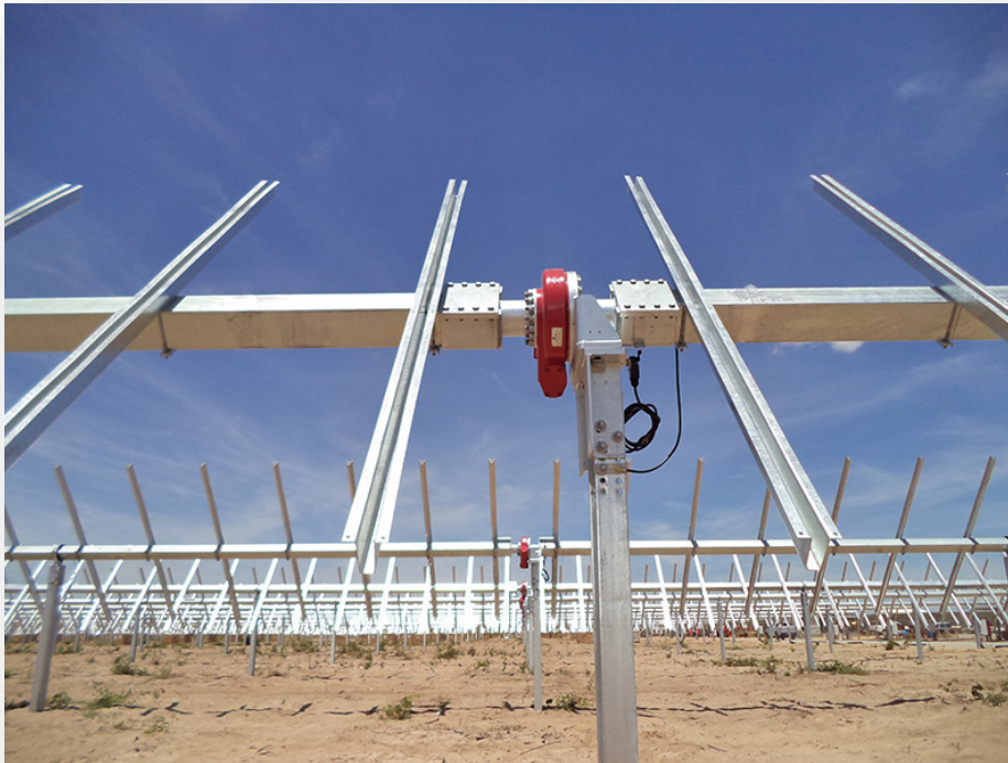
Figura 2 – Struttura dell'inseguitore solare monoassiale
