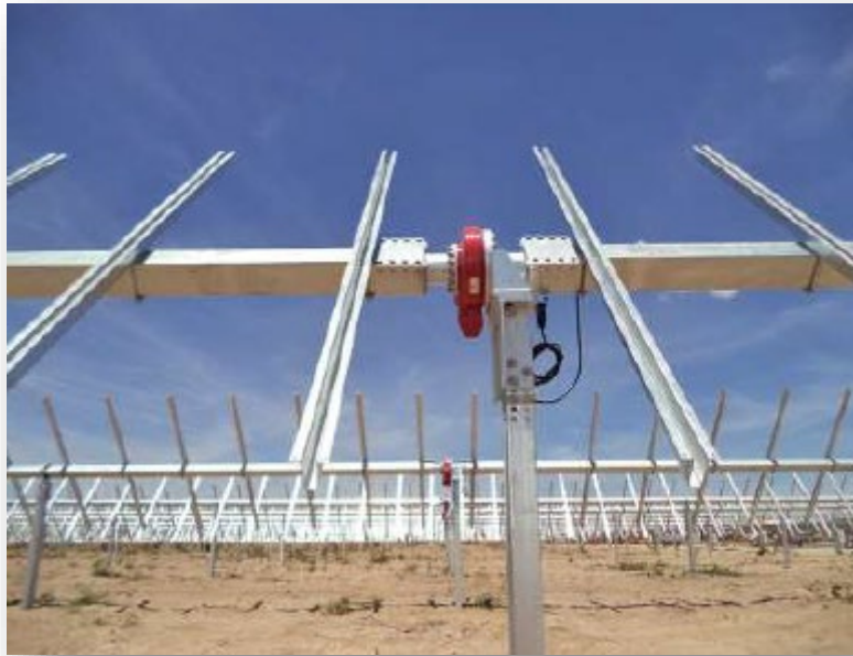
Figura 9 - Struttura dell'inseguitore solare monoassiale
