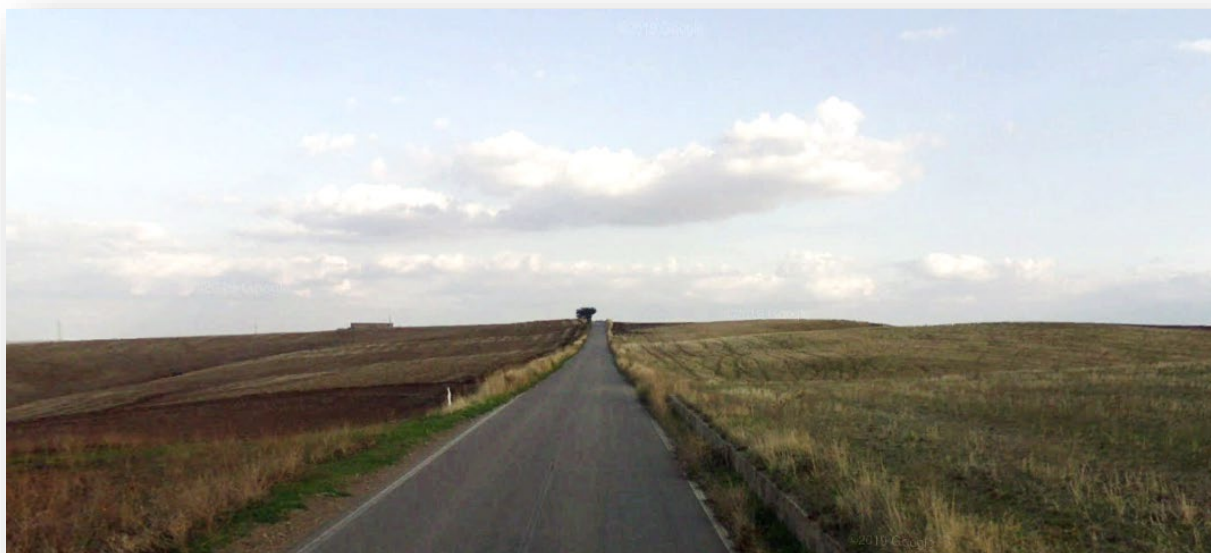
Figura 3 – Esempio strada di accesso al parco
