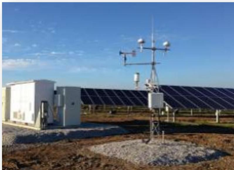
**Figura 34 - Stazione meteorologica tipo**
