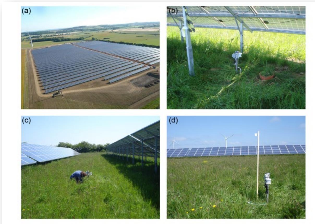
Figura 35 - (a) foto aerea del Westmill Solar Park; (b) Under: punto di rilevamento sotto i moduli; (c); Gap: punto di rilevamento tra i filari di moduli; (d) Control: punto di rilevamento esterno
