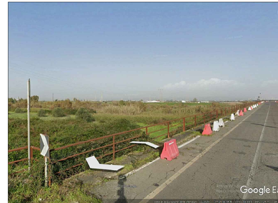
INTERFERENZA 2 - Ponte Fiume Simeto
