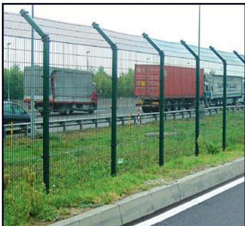
La recinzione continua lungo il perimetro dell'area d'impianto sarà costituita da elementi modulari rigidi in tondini di acciaio elettrosaldati di diverso diametro che conferiscono una particolare resistenza e solidità alla recinzione. Essa offre una notevole protezione da eventuali atti vandalici, lasciando inalterato un piacevole effetto estetico e costituisce un sistema di
