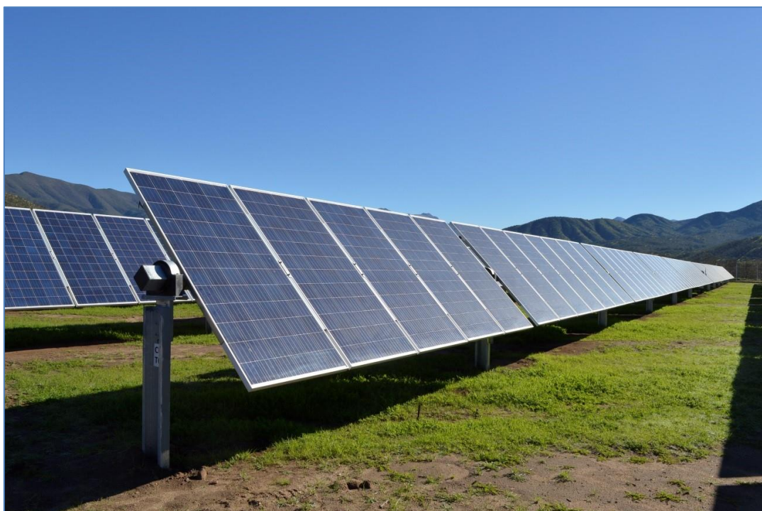
Fig. 34 - Inseguitori mono-assiali in configurazione 1P
