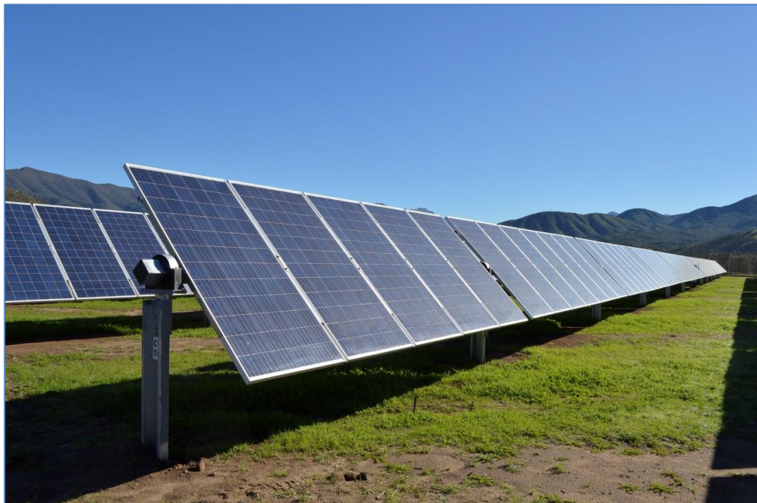
Fig. 16 - Inseguitori mono-assiali in configurazione 1P
