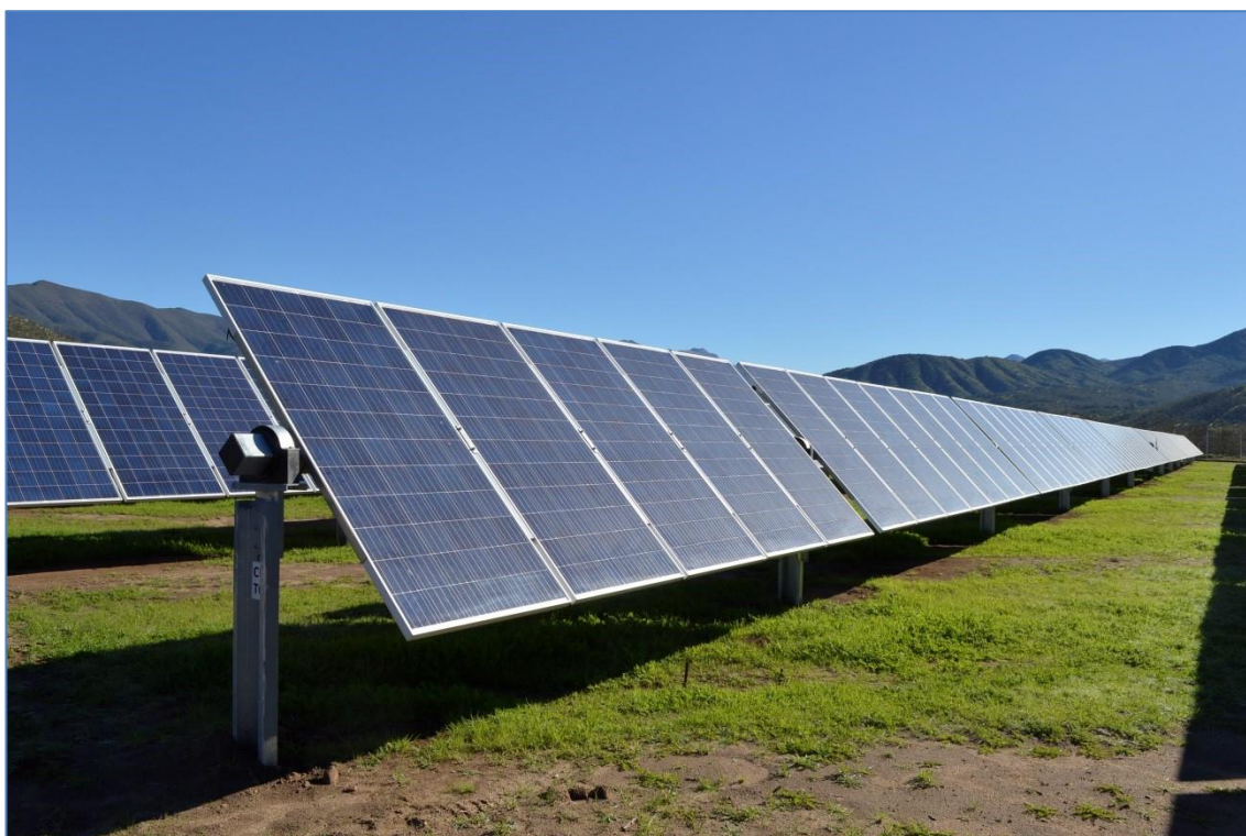
Fig. 18 - Inseguitori mono-assiali in configurazione 1P
