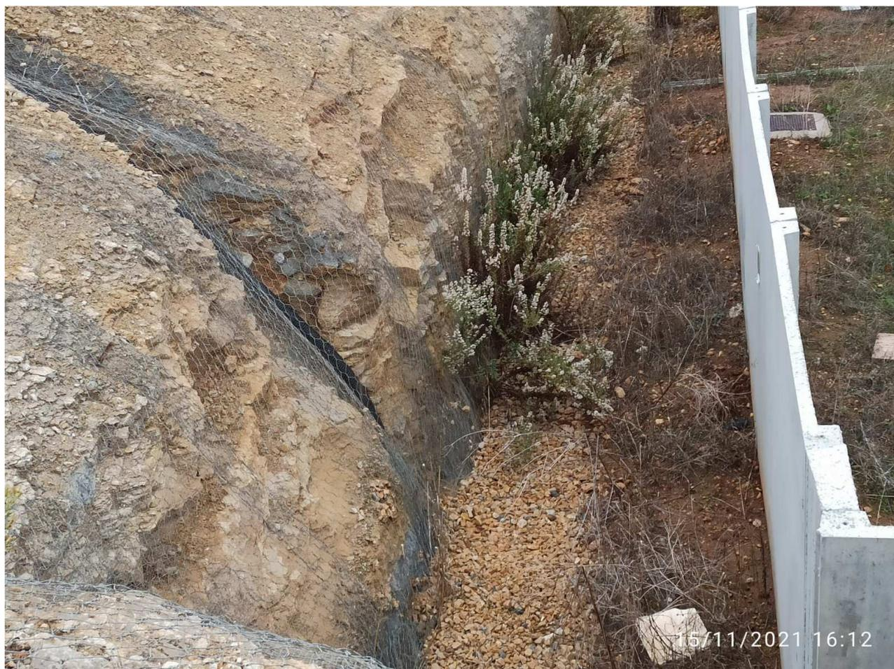
**Figura 5.1 - Dettaglio del fronte di scavo in prossimità della stazione elettrica di Terna S.p.A.**
