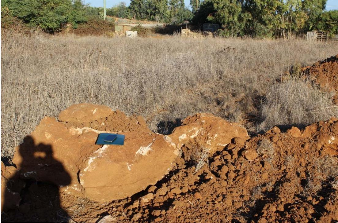
**Fig. 3** ulteriori scavo eseguiti in prossimità del pozzetto Pz1, particolare dei grossi blocchi calcarei.
