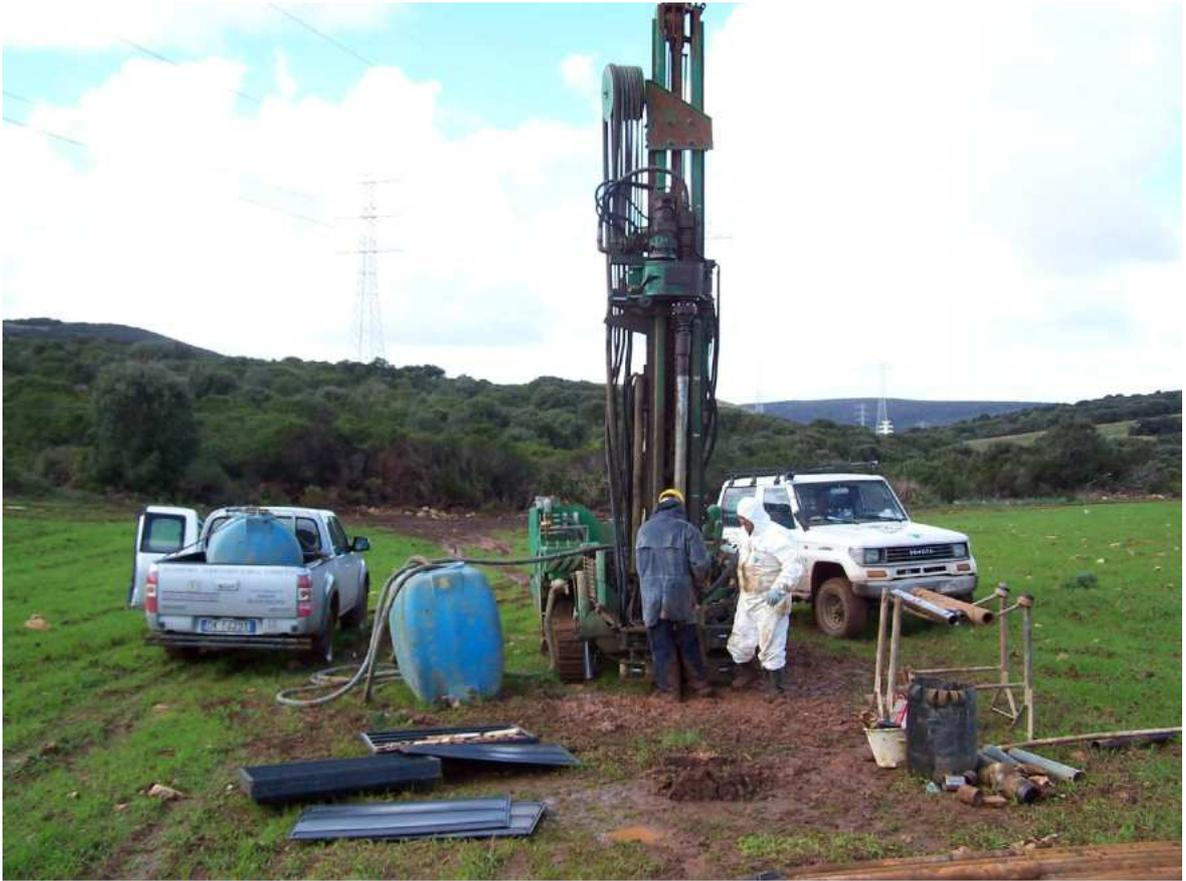
**Foto n° 15 – Particolare dell'esecuzione del sondaggio geognostico S1**
