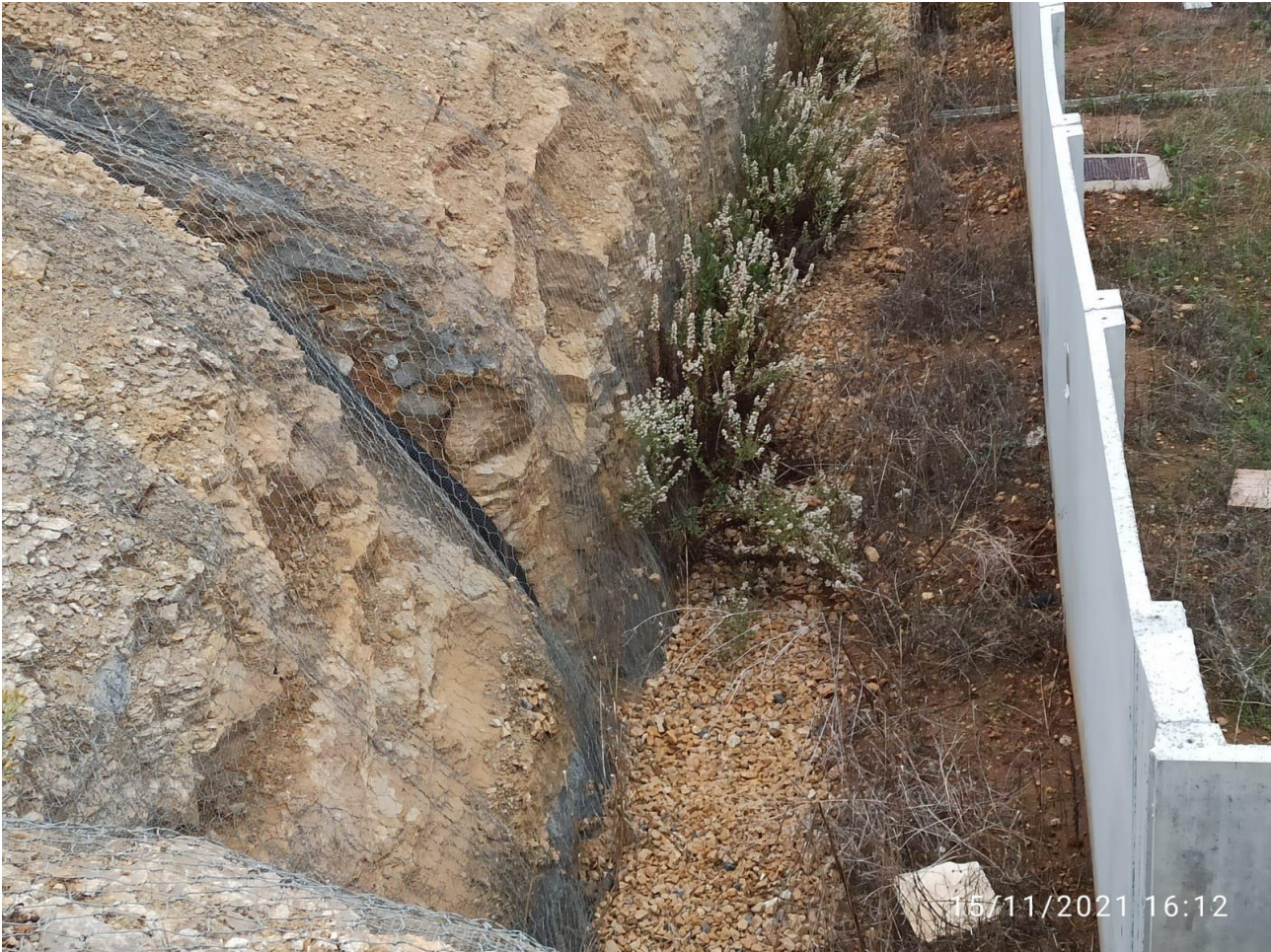
Figura.2- Dettaglio del fronte di scavo in prossimità della stazione elettrica di Terna S.p.A.
