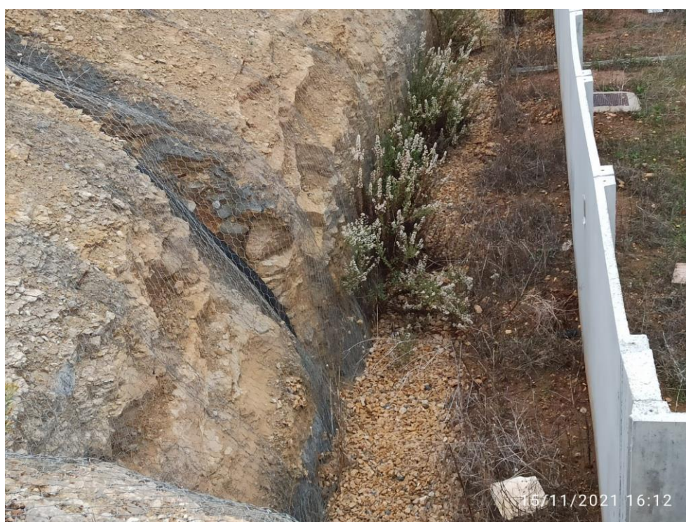
Figura IV.26- Dettaglio del fronte di scavo in prossimità della stazione elettrica di Terna S.p.A.
